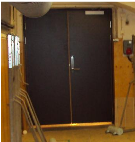
Figur 13. Stor glipa i brandcellsgräns
