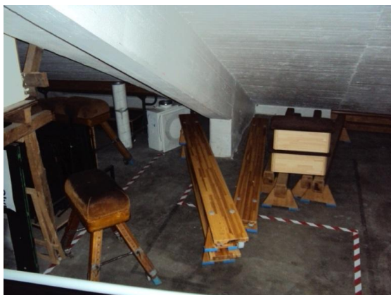
Figur 16. Förrådet under norra läktaren
