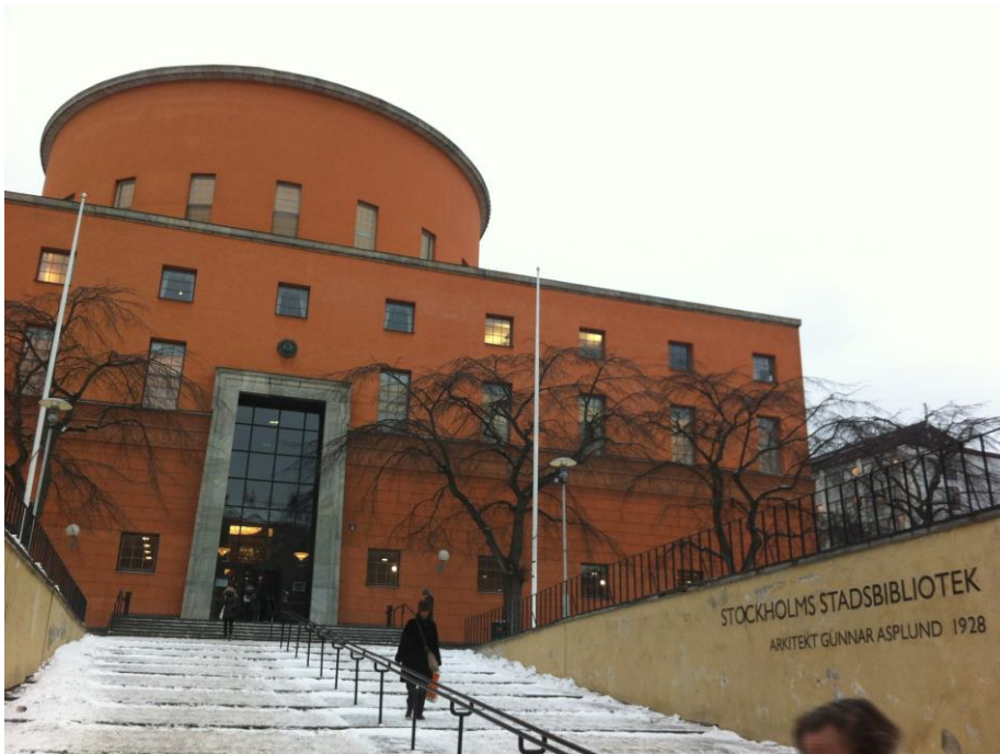
Figur 2. Bibliotekets huvudentré med fasad och rotunda.
