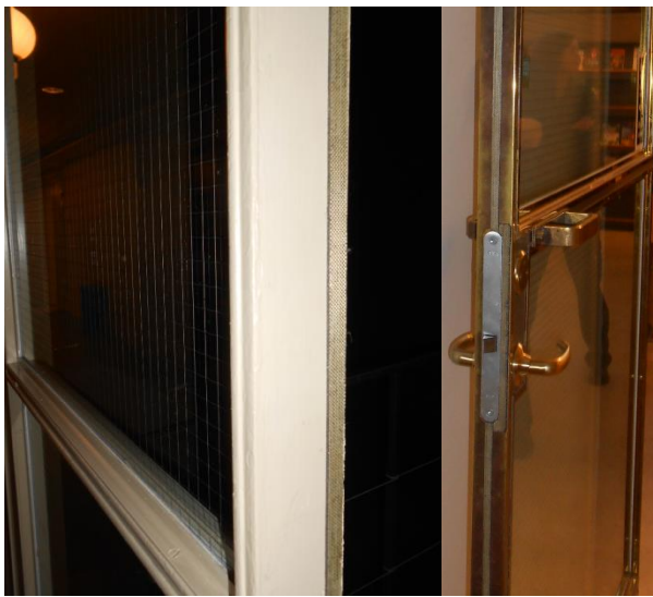
Figur 9. Exempel på var svällister sitter monterade på dörrblad.
