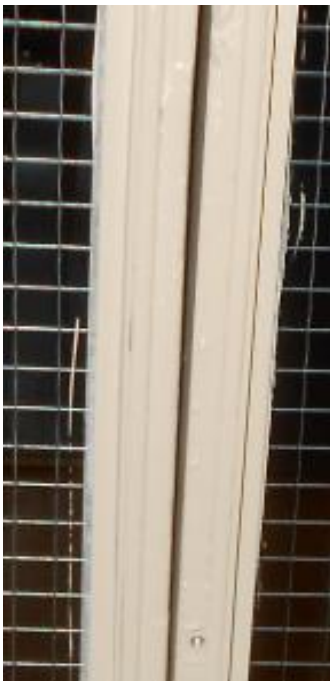
Figur 11. Exempel på utrymme mellan dörrblad där svällist saknas.
