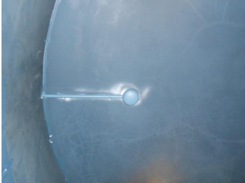
Figur 10. Övermålad rökdetektor placerad i sagorummet.
