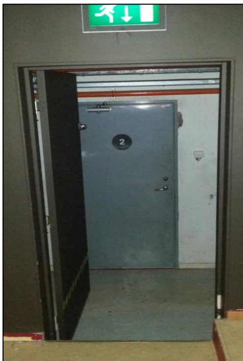
Figur 10-3 - Bild på den andra nödutgången i bowlinghallen. Denna står öppen mot utrymningsväg.
