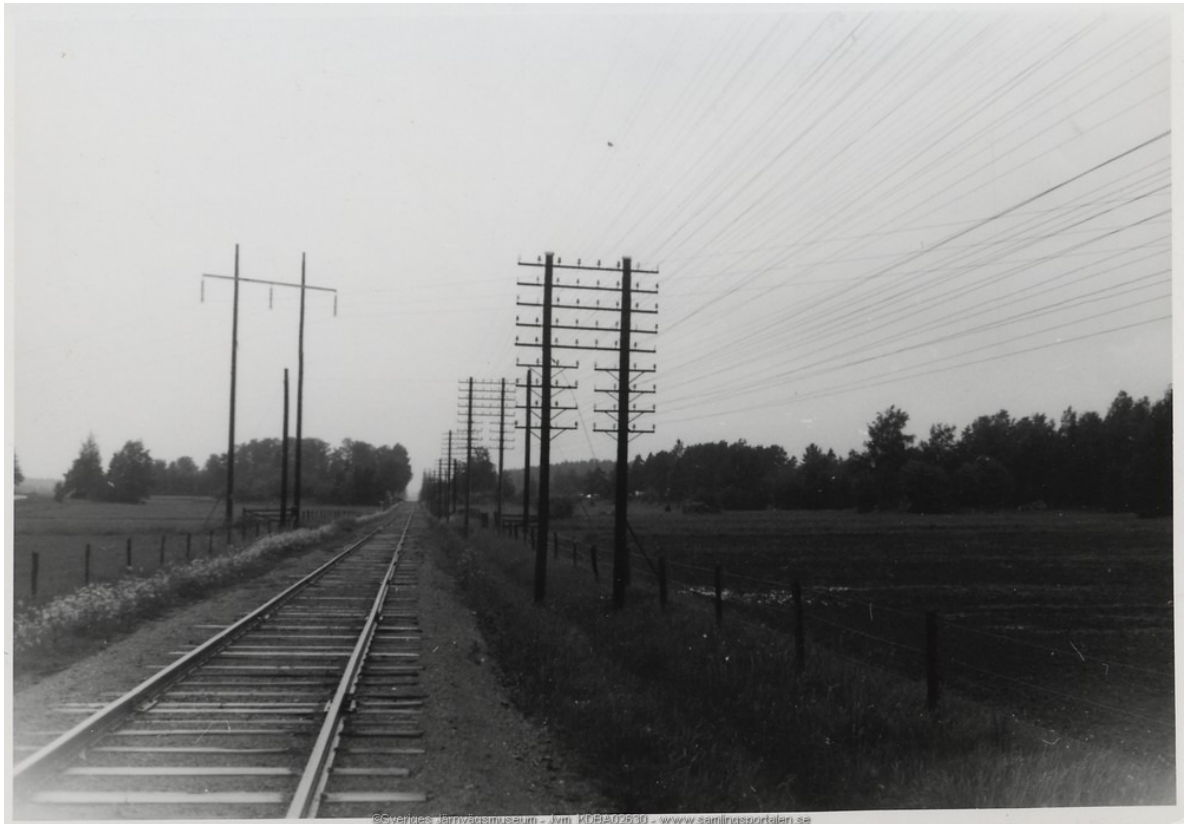
Figur 7. Illustration över telekablar, innan de grävdes ned. (Sveriges Järnvägsmuseum, Trafikverket, 2014).
