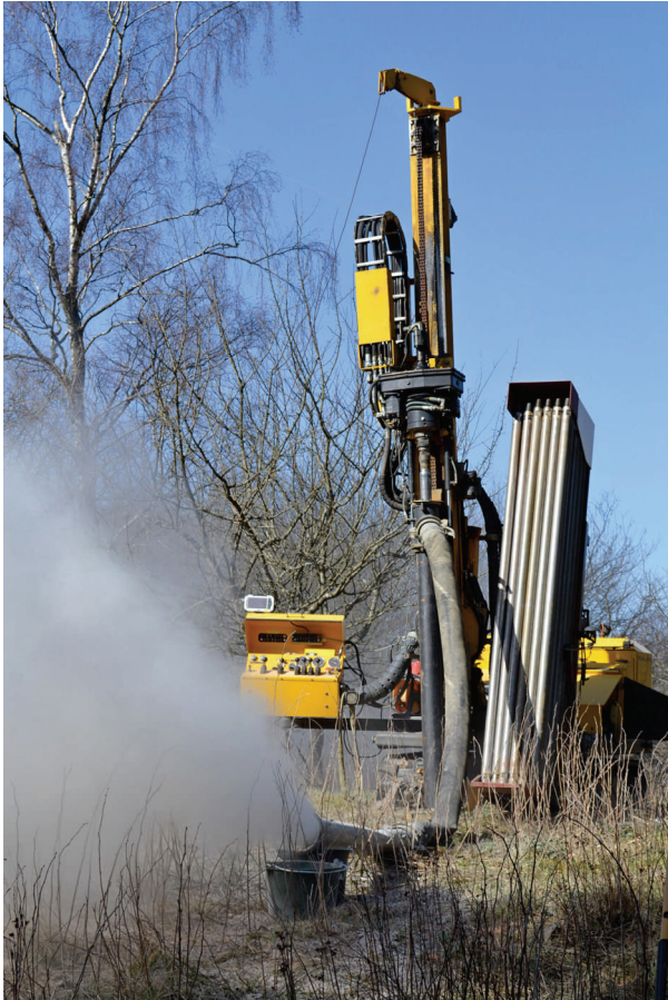
Fig. 8. Borriggen under pågående borrhning av B1. Den vita röken är borrhkax som blåses ut med hjälp av tryckluft.
