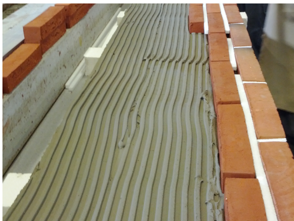
FIGUR 7.2: Applicering av tegelskärvor
