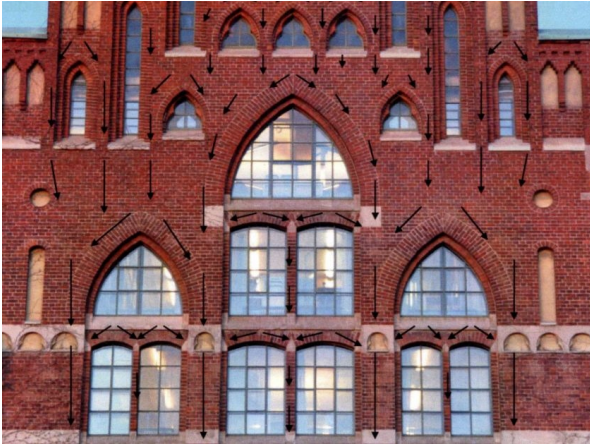
FIGUR 1.1: Tegelfasad med fördelaktig överbyggnad av öppningar [2]
