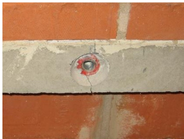
FIGUR 9.1: Betongen är helt uppsprucken vid lyftankaret
