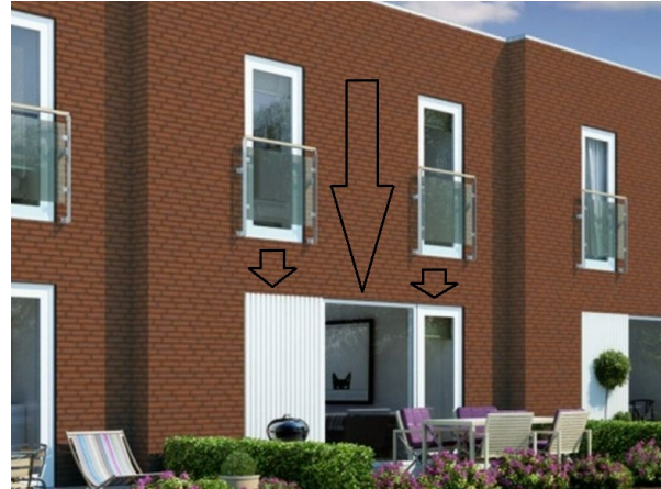
FIGUR 1.2: Tegelfasad som kräver särskilda åtgärder angående bärformågan [3]
