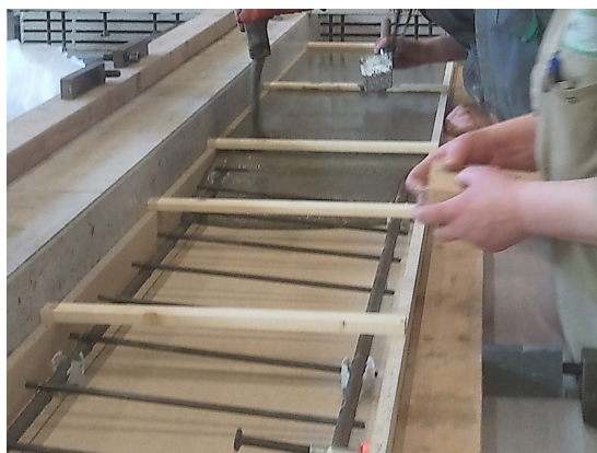
FIGUR 7.1: Gjutning av betongelement
