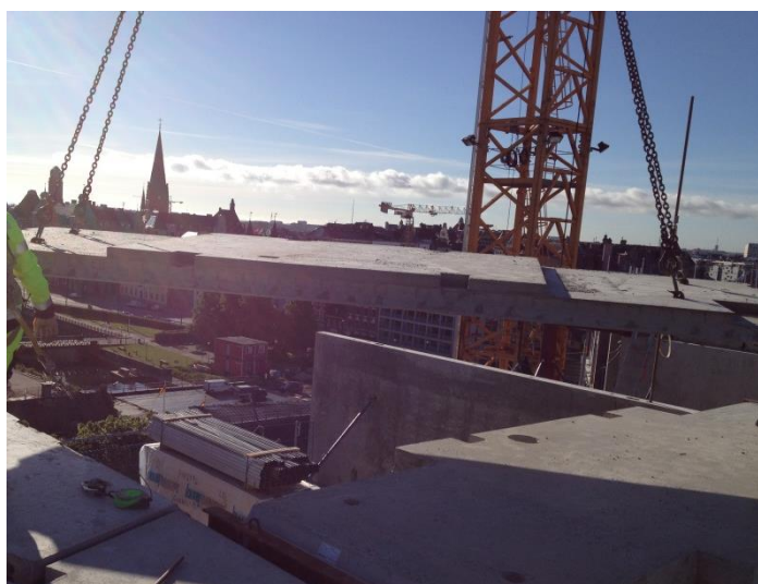
Figur 5 - Bjälklag monteras
