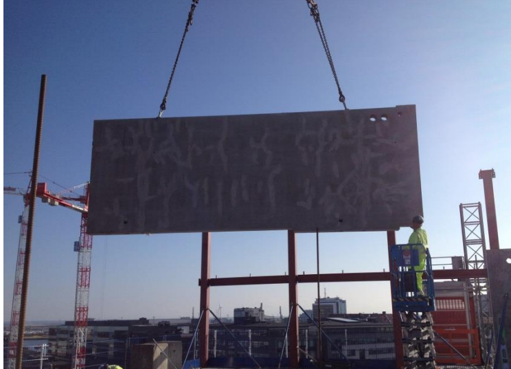
Figur 6 - Innervägg monteras
