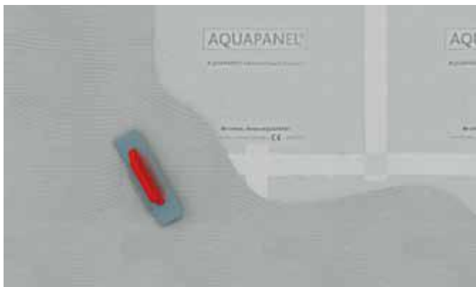
Figur 2.12. Putsning av skivans yta (Knaufdanogips, 2012).
