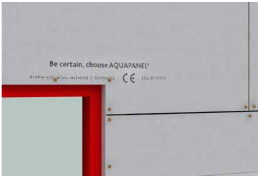
Figur 2.10. Rätt placering av skivor kring karmsidor (Knaufdanogips, 2012).
