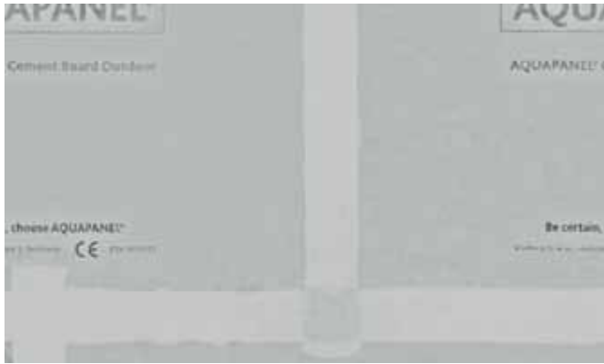
Figur 2.11. Spackling och armering av skarvar (Knaufdanogips, 2012).
