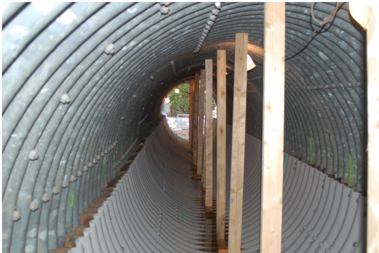
Figur 8 Rörbro just innan gjutning av betongen. Träpålarna ska motverka betongens lyftkraft (Lundström, et al., 2012)
