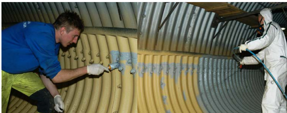
Figur 12 Applicering av polyesterplast (Sönksen, 2012)
