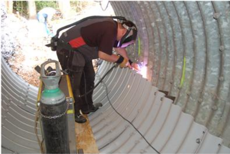
Figur 7 Infästningen mellan det gamla röret och den nya rörhalvan svetsas på plats. (ViaCon, 2010)
