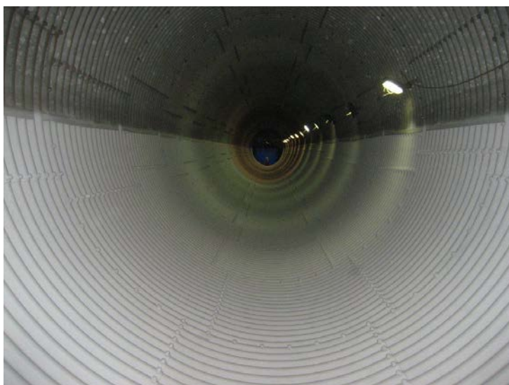
Figur 13 Rörbro efter att applicering av specialplasten gjorts. (Sönksen, 2012)
