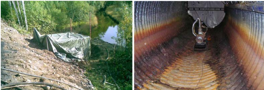
Figur 11 Objektet värms upp och torkas (Sönksen, 2012)
