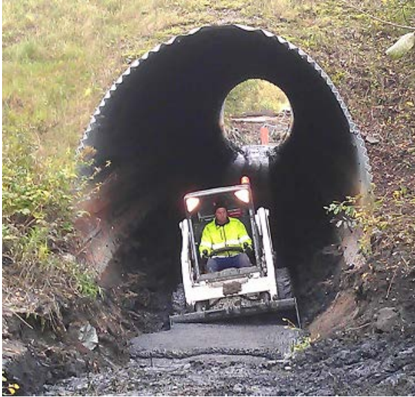
Figur 10 Rengöring av rörbro innan reparation. (Sönksen, 2012)
