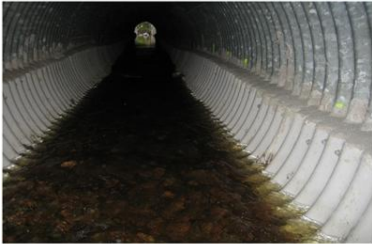
Figur 9 Reparerad rörbro med halvsulning (ViaCon, 2010)
