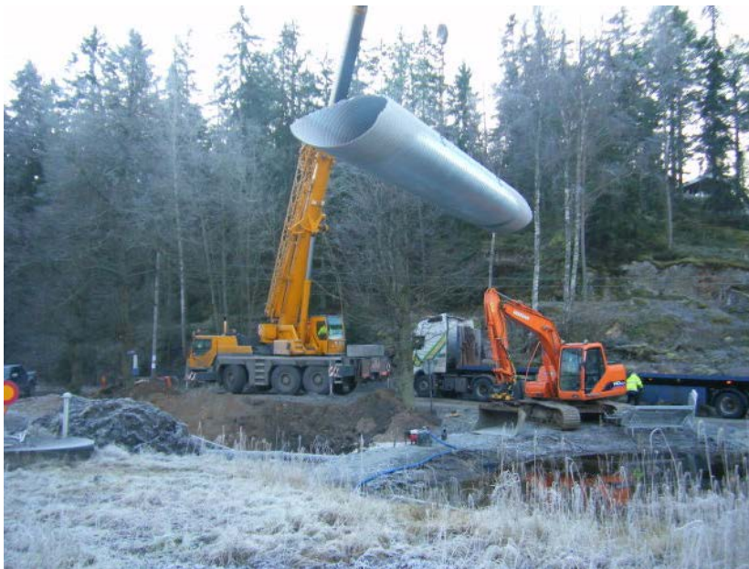
Figur 14 Utbyte av rörbro vid Isättravik (Andersson, 2012)
