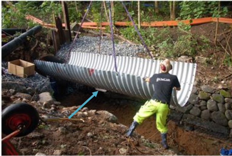
Figur 6 Den nya rörhalvan lanseras. Notera löparna på undersidan av det nya röret. (ViaCon, 2010)
