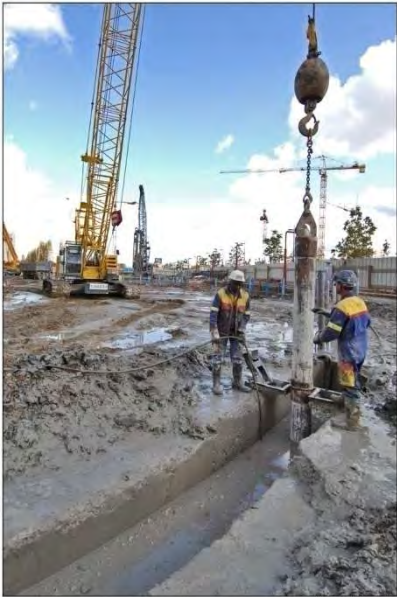
Picture 9 : concrete pouring
