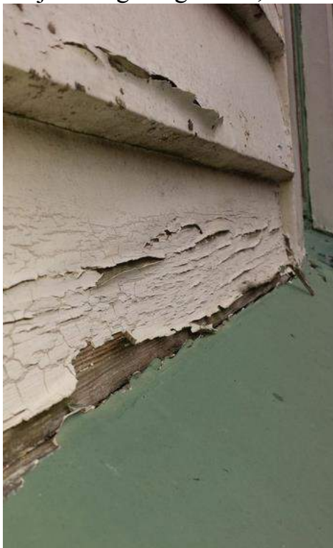
Bild: Övergång mellan västra flygelns avrinningsplåt och panelen
