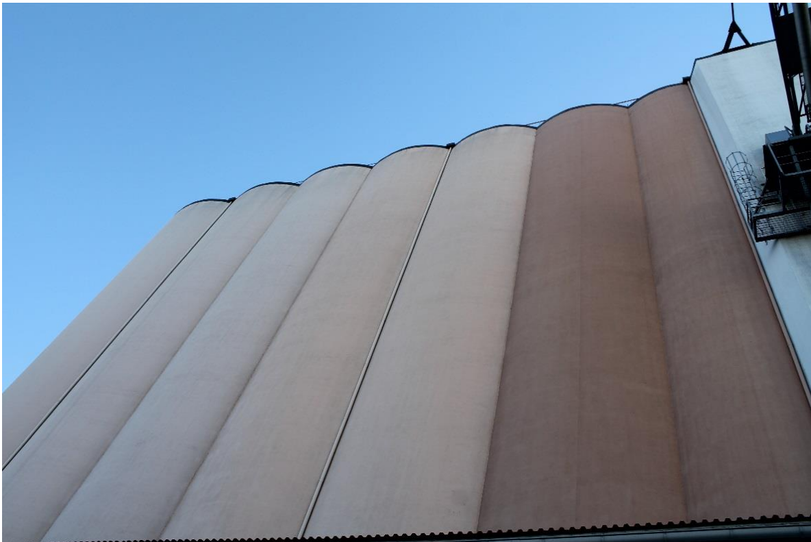
Figur 7 Bild från norr på silobatteriet. Här syns de extra förvaringsutrymmena i form av halvmånar, som byggts på i efterhand.
