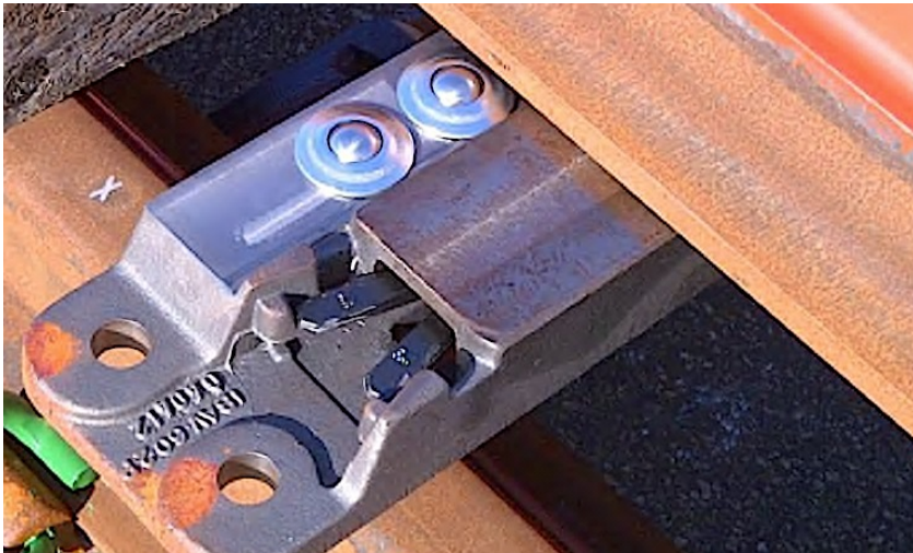
Figur 5: Kulrullar från en UIC60-växel. Källa: Intervju L1
