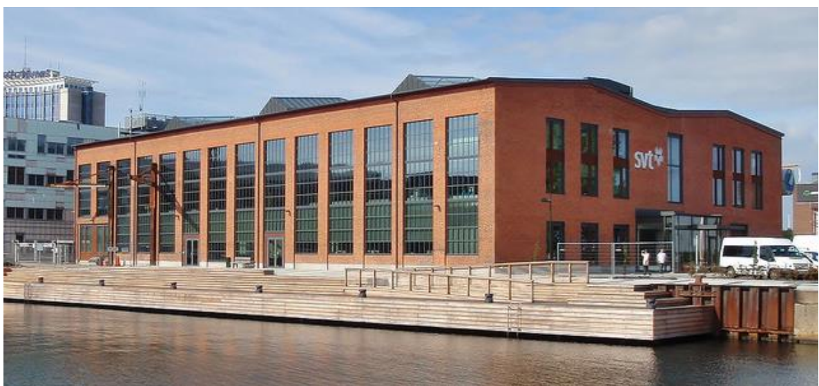
Figur 1.1: SVT-husets södra och östra fasader (Temagruppen, 2014).
