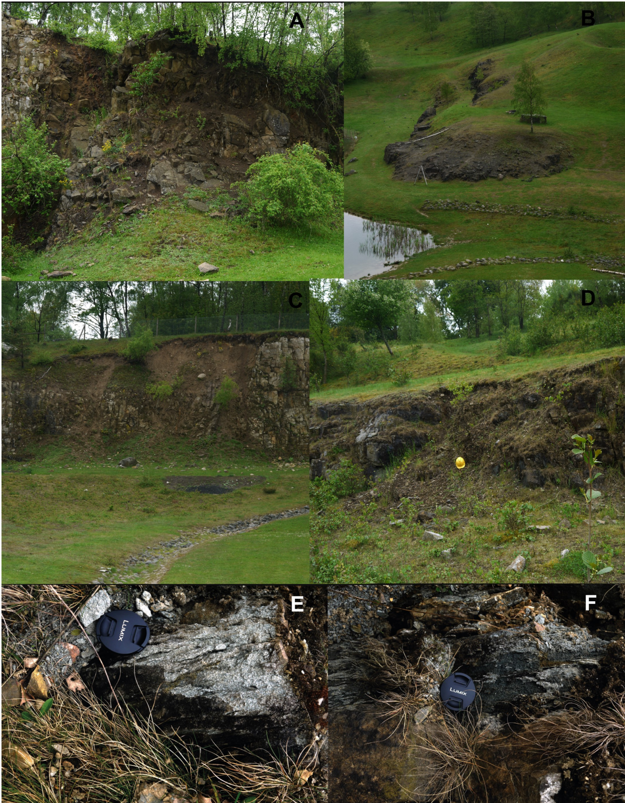
Fig. 20. Figur A diabasgången i nordväst, punkt 11 på kartan. Figur B diabasgången på sydöstrasidan av Skryllesjön, punkt 11 på kartan. Figur C diabasgången i väster, på den stora skärningen, punkt 12 på kartan. Figur D diabasgången som är ordentligt vittrad, punkt 12 på kartan. Figurer E & F visar exempel på den vittrade diabasgången vid sydöstra hörnet av Skryllesjön, punkt 12 på kartan. Alla foton an H. Tuveesson
