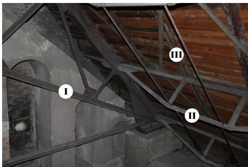
Figur 4.4: Loftet över södra transeptet med primär- sekundär- och tredje ordningens bärverk markerade med I-III.
