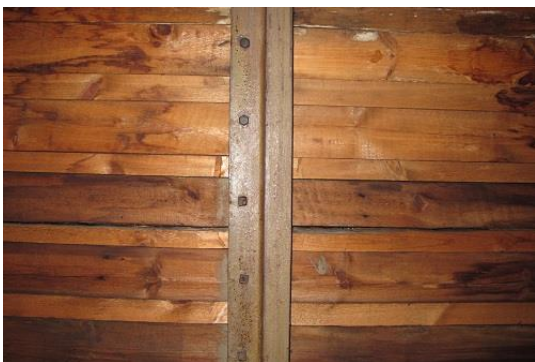
Figur 4.15: Uppbyggnaden av fjärde ordningens bärverk. I mitten på bilden syns tredje ordningens bärverk.
