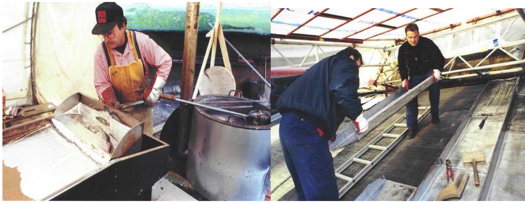
Figur 4.12: BM-plåt i Lomma lägger om blytaket på södra sidoskeppet 1999-2000.
