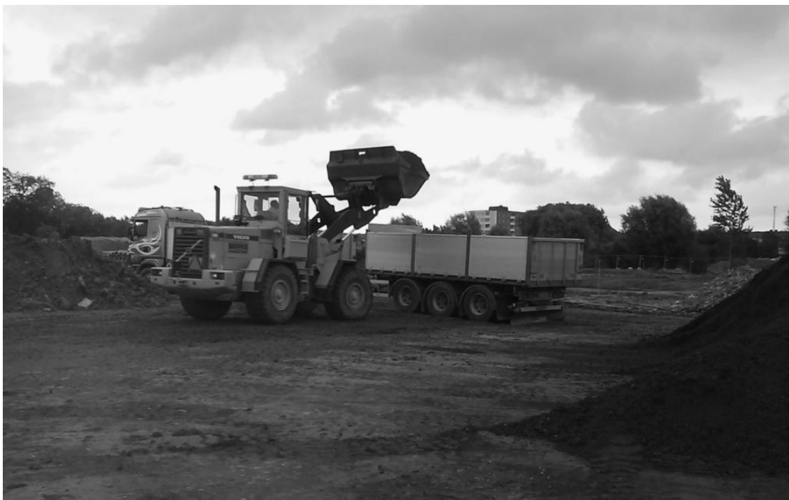
Figur 5-5. Lastning av förorenade massor, Lomma Hamn
