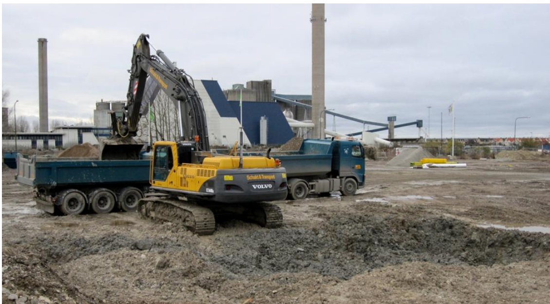
Figur 7-7. Schaktning av hotspot med oljeförorenade massor, med omedelbar lastning för transport till deponi.
