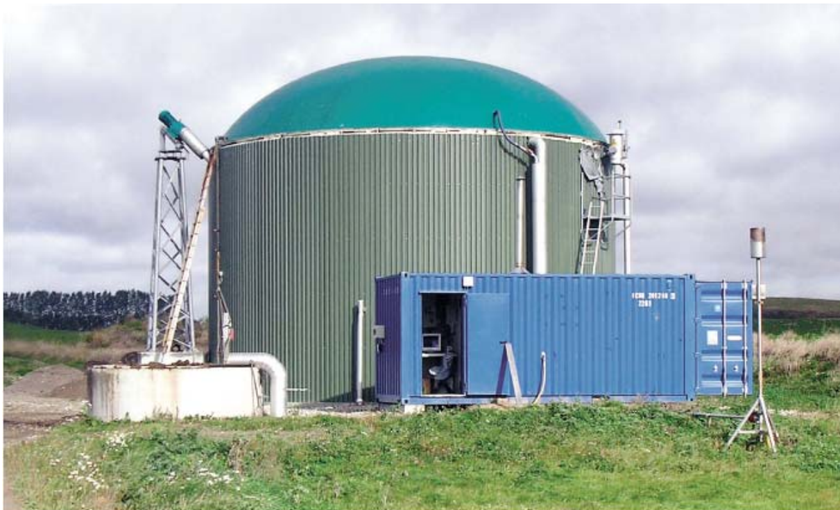
Hagaviks biogasanläggning. Foto: Anna Hansson.
