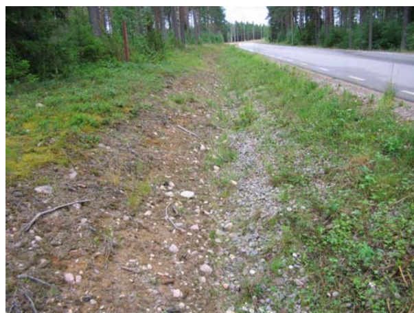
Bild 56. Vissa av de utflackade bakslänterna har fortfarande mycket gles vegetation (1452748;6761772)
