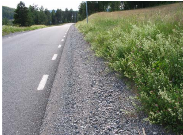
Bild 61. Delvis sparad bakslänt och täckt dränering vid Sandviken 1. (1521269;7050165)
