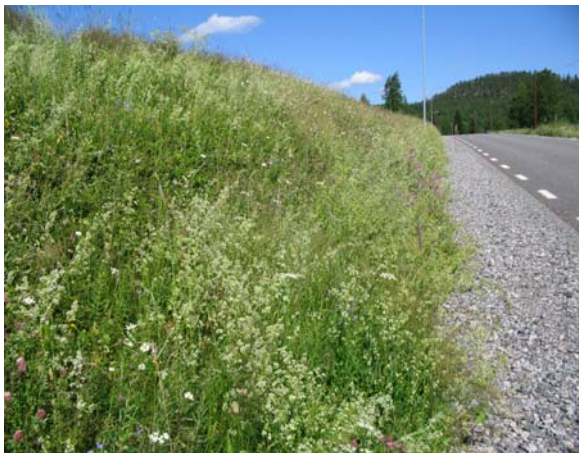
Bild 62. Sparad bakslänt och täckt dränering vid Sandviken 2. (1521225;7050123)
