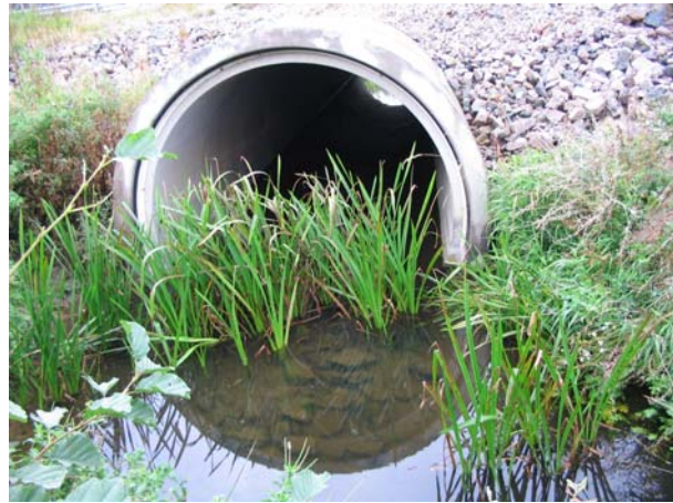
Bild 54. Den nya rörbrons utlopp. Botten utgörs i anslutning till bron delvis av stenkross. (1355315;6154502)
