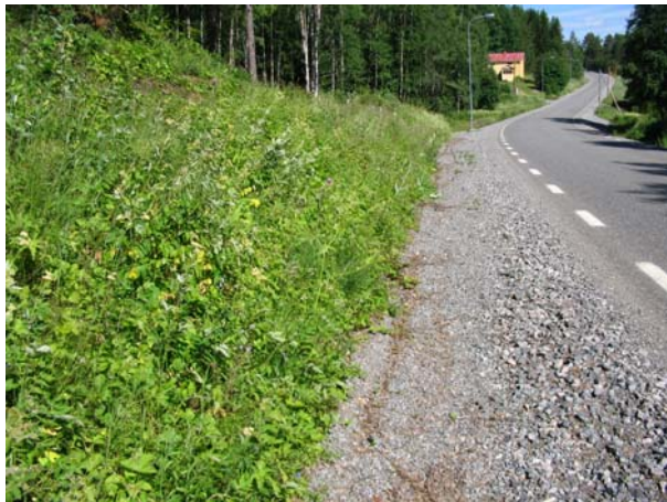
Bild 63. Sparad bakslänt och täckt dränering vid Sandviken 4. (1520715;7049896)
