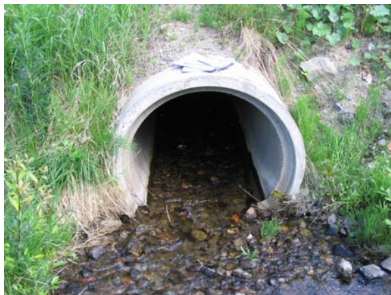
Bild 17. Väl miljöanpassad trumma vid Gällnäkrogen (1426879;6950308)
