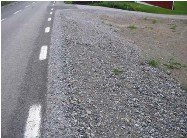
Bild 41. Dålig återetablering på slänterna inne i byn (höger och vänster sida om vägen 1361857;7014763).
