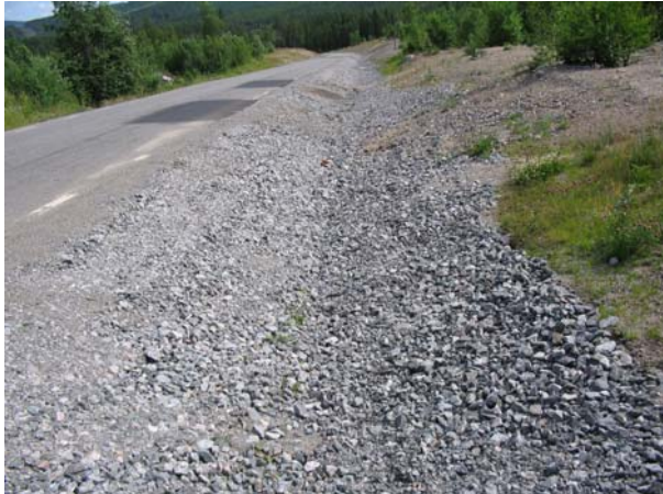
Bild 59. Rätad kurva vid kvarnbergsbacken. Här lades en kompletterande djupdränering året efter projektets färdigställande. Krossgrus behövde därför läggas en bit upp i ytterslätten. (1523196;7051576)
