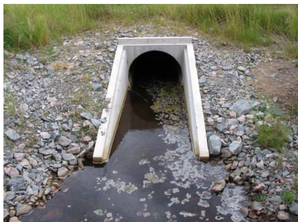
Bild 8. Förlängd trumma med naturligt bottensubstrat. (1566924;6787646)
