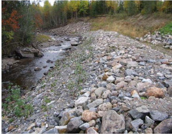
Bild 28. Erosionsskydd i Granån. Al planterat på skyddsvallen. (1508970;6930969)
