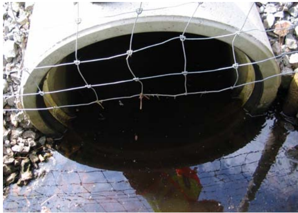
Bild 19. Stenkulvert förlängd med betongtrumma (1578077;6726724)
