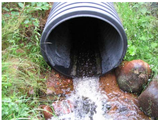
Bild 71. Högt lagd trumma i en större bäck strax sydväst om Stackmora (1437536;6779355)
