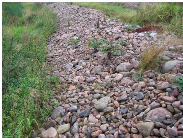
Bild 23. Erosionsskydd av natursten på slänt mot väg 110 (1316285;6222796)
