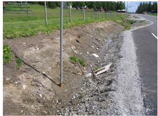
Bild 41. Dålig återetablering på slänterna inne i byn (höger och vänster sida om vägen 1361857;7014763).
