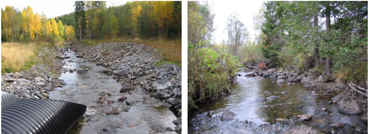
Bild 26. Hegelån. t.v.: omgrävd sträcka nedströms rörbron (1509048;6930994), t.h.: opåverkad sträcka uppströms rörbron (1509016;6931001)
