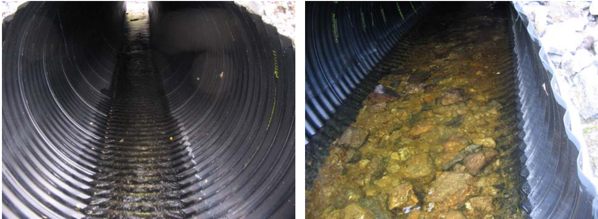
Bild 30. Bottensubstrat i en av rörbrons trummor. T.v.: inlopp utan naturligt bottenmaterial (1509025;6930995) t.h.: utlopp med en naturlig sten- och grusbotten (1509048;6930998)
