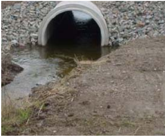
Bild 53. Sträckan uppströms rörbron strax efter avslutat projekt. (Foto från slutbesiktningen)
