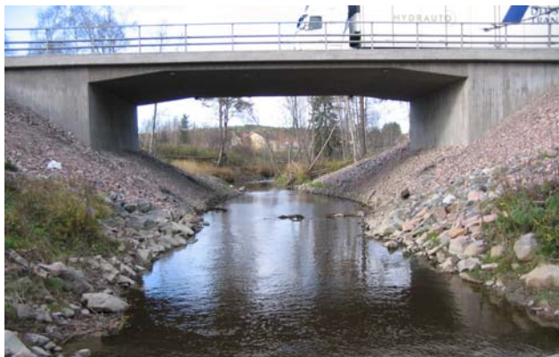
Bild 9. Hela den omgrävda sträckan vid bron.
