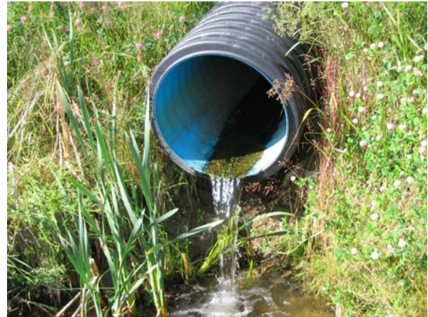
Bild 37. Trumma med kraftigt fall vid nedströmsänden (1545841;6753802)
