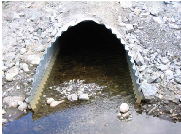
Bild 42. Nedströmsänden av den ovala trumman i Storbäcken. Fin naturlig botten. (1364322;7015317)
