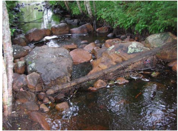
Bild 58. Trösklingen är utförd genom utläggning av två dämmen av natursten.
