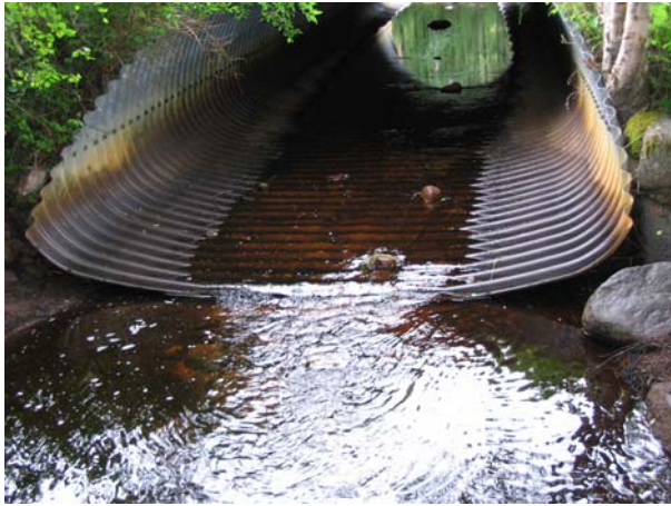
Bild 57. Rörbron i Rejån. Efter tröskling finns inget fall bakom den för högt lagda trumman ens vid det låga flöde som rådde vid fältbesöket.
