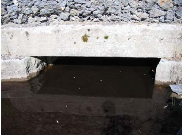
Bild 21. Stenvalv där Valedbäcken passerar under GC-vägen. Bäckbotten är intakt (1561623;7006392)
