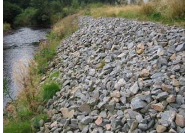
Bild 3. Åbank med ej övertäckt stenkross ned mot ån (1339244;6239238)
