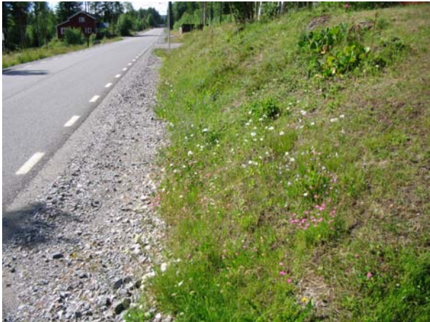
Bild 66. Sparad bakslänt och täckt dränering vid Vallen 2. (1519266:7049753)
