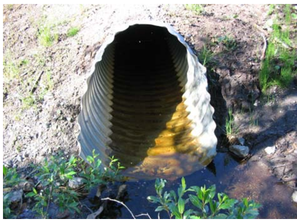
Bild 49. Trumma utan naturligt bottensubstrat i Fagerlandsbäcken (1469797;7034305)
