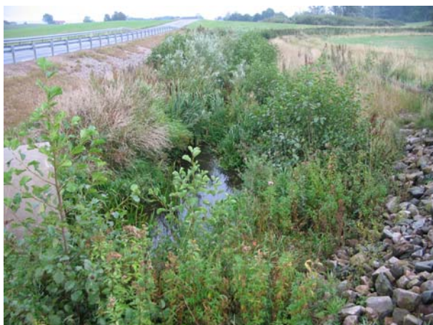
Bild 51. Hela den omgrävda sträckan nedströms rörbron, rikligt med klibbal och pil planterat (1355294;6154502)
