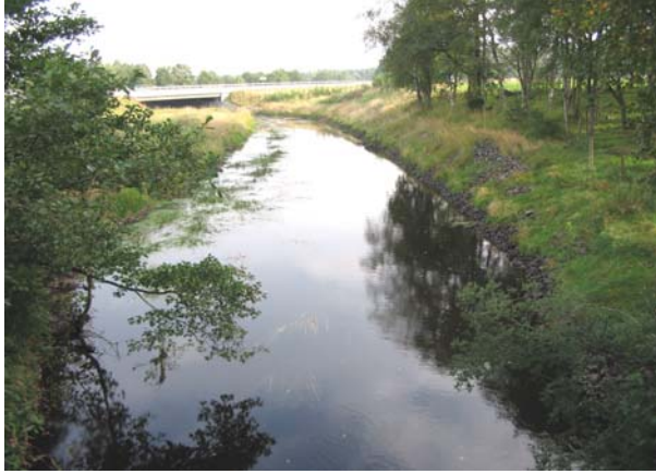
Bild 2. Ny åfåra (vy mot E4-bron). Snabb etablering av växtlighet på strandbankarna; grässådd genomförd (1339497; 6239481)
