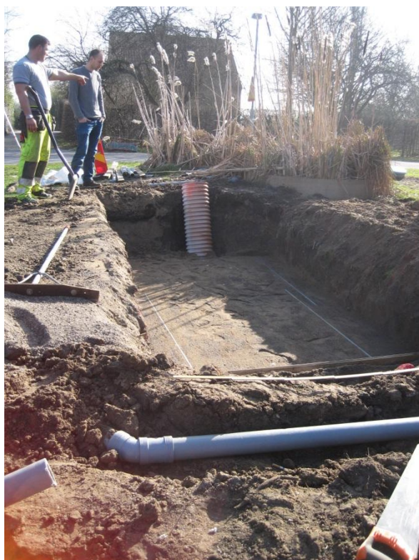
Figur 4: Konstruktion av rotzonsanläggningen i Alnarp
