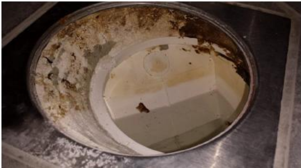
Figur 18: Sned sil (Länsförsäkringar Skåne 2013)
