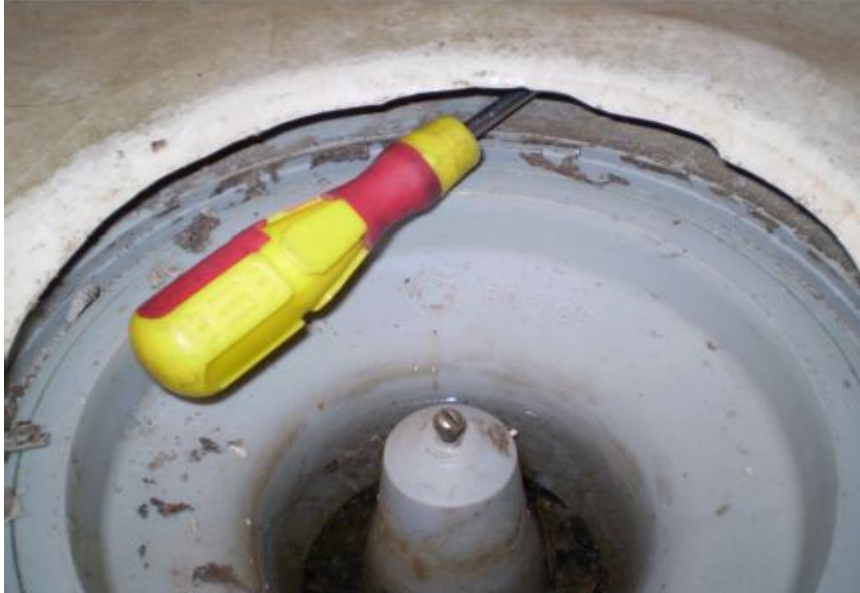
Figur 20: För kort plastmatta (Länsförsäkringar Skåne 2009)
