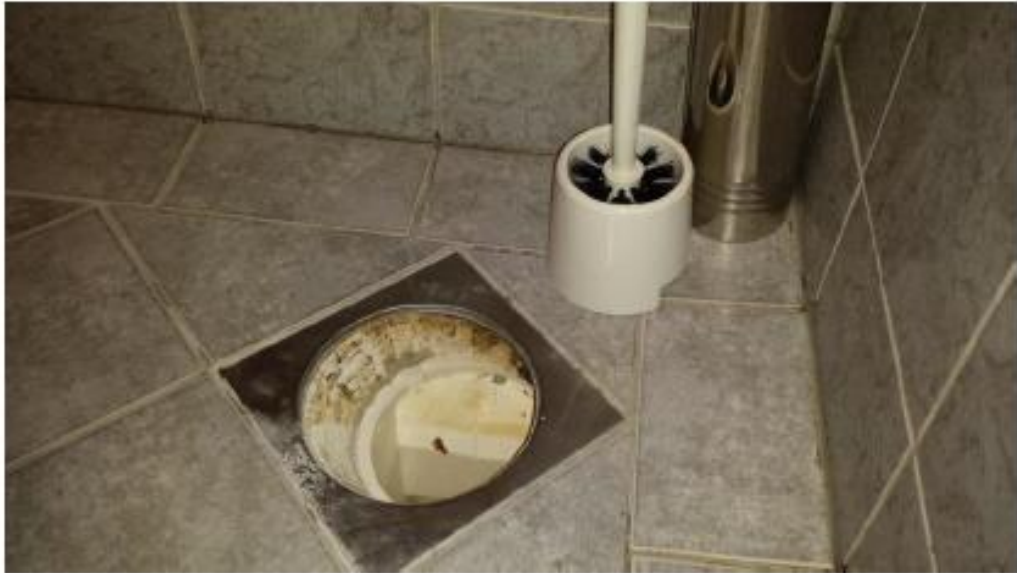
Figur 17: Mönsterinpassad sil (Länsförsäkringar Skåne 2013)
