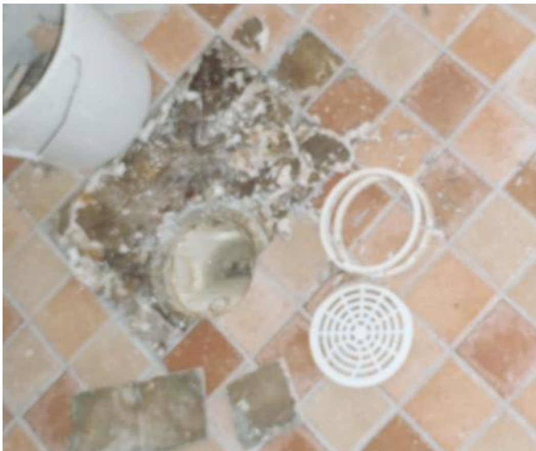
Figur 13: Felaktig förhöjningsring (Länsförsäkringar Skåne 2012)
