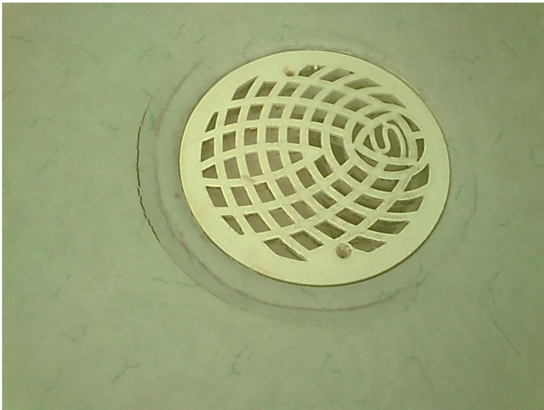
Figur 19: Sprucken plastmatta runt brunn (Länsförsäkringar Skåne 2012)
