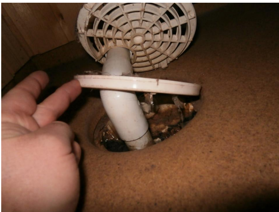
Figur 12: Lös klämring (Länsförsäkringar Skåne 2012)
