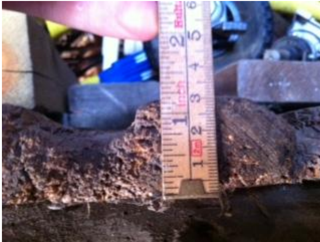
Figur 2.10 (Foto A.Månsson) Vindsgolvets plankor har en varierande tjocklek; ca30 mm.
