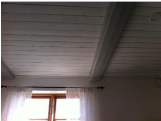
Figur 2.9 (Foto A.Månsson) Innertaket med synliga takbalkar och råspont som innertak.
