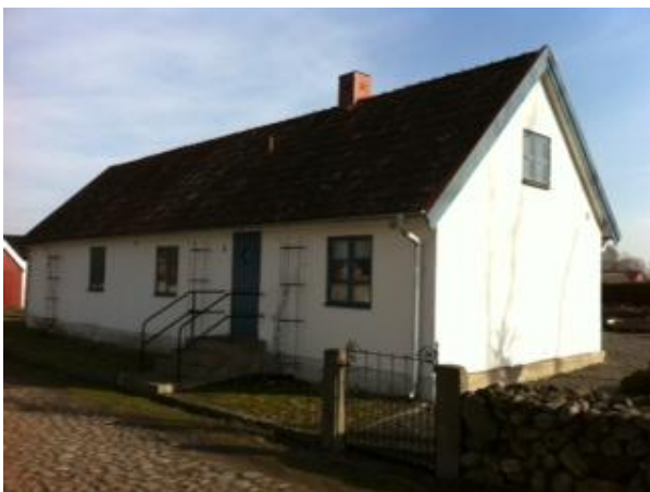
Figur 2.2 (Foto A.Månsson) Husets långsida mot väster och den medeltida gatan.
