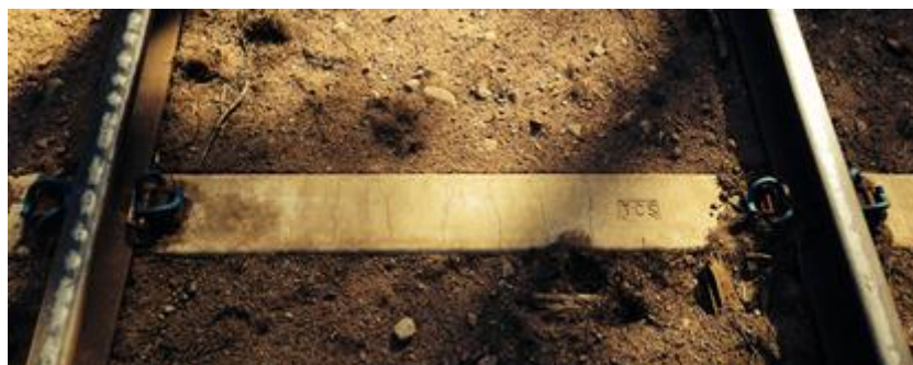
Figur 7: Bilden visar förknäckningssprickorna i en TCS.
