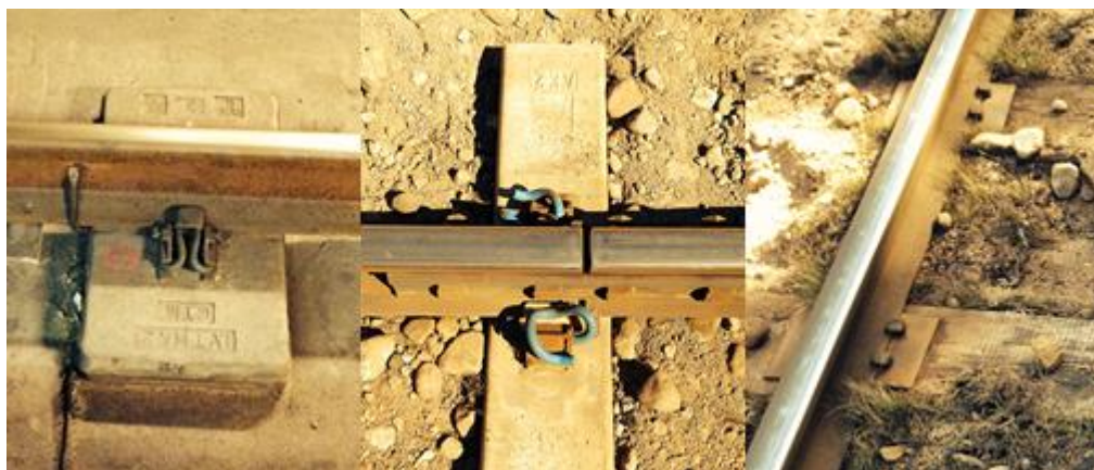
Figur 4: Bilderna visar hur de olika befästningarna som nämnts ovan ser ut, Pandrol fast-clip, Pandrol e-clip och Spikbefästning
