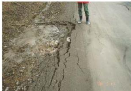
Deformation av vägbanekant
