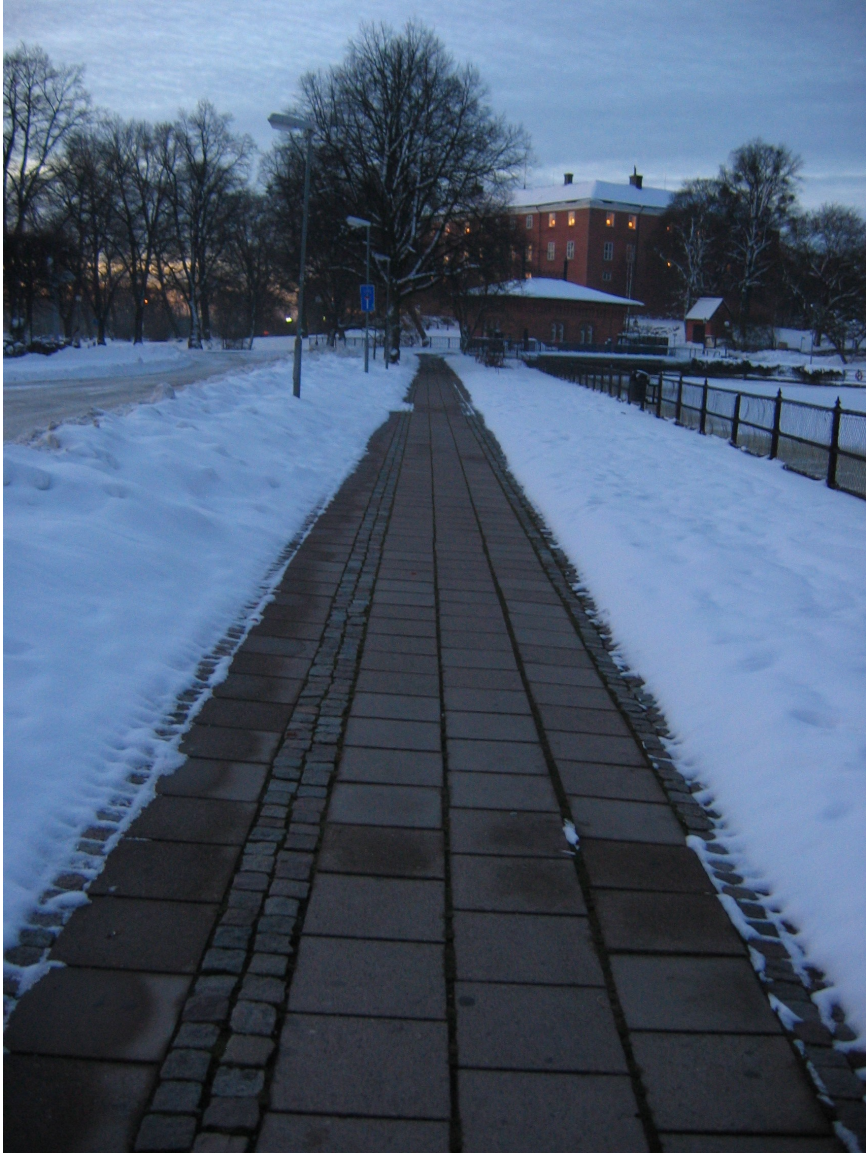
Bild 13. Uppvärmad gångbana (Almén, 2014).
