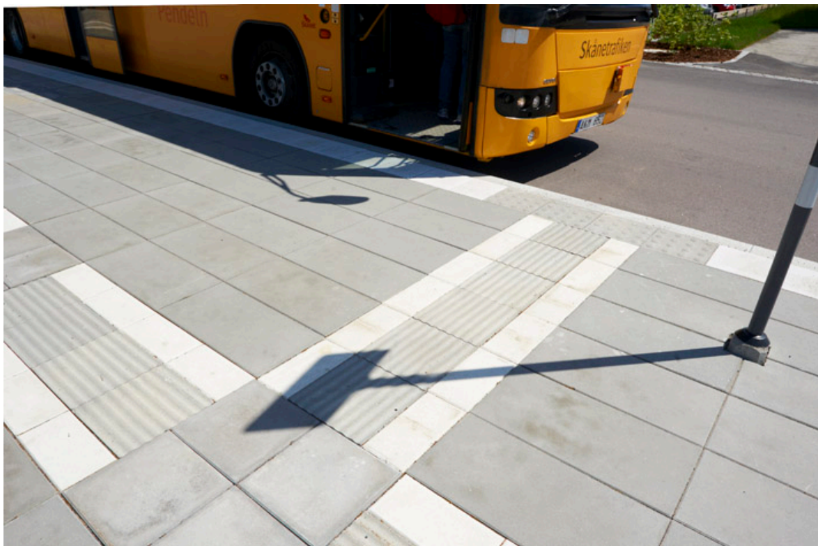
Bild 3. Kupolplattor, sinusplattor och släta plattor vid en busshållplats (Starka, 2014).
