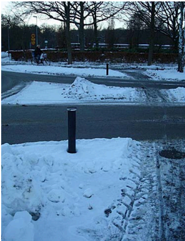
Bild 14. Ej snöröjd pollare vid övergångsställe, dessutom felvänd riktningvisare (Grönvall, 2004).
