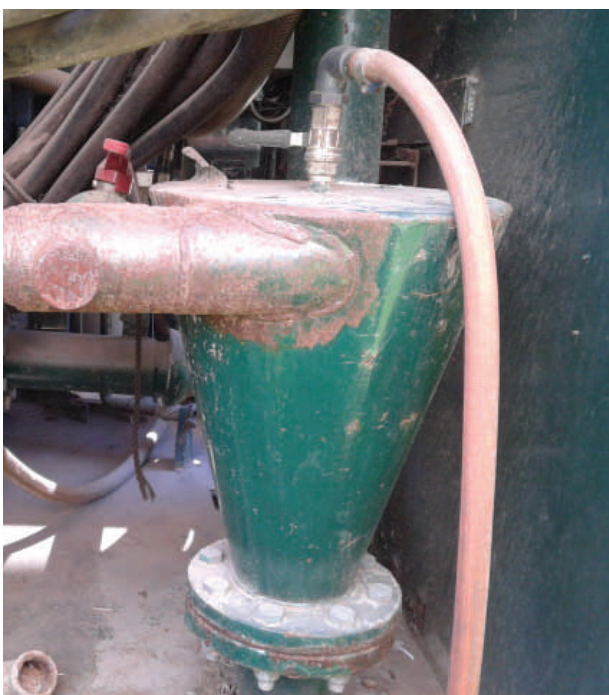
Fig. 22: Fotografi föreställande en hydrocyklon (t. v.) samt en schematisk sketch som visar hur den fungerar (t. h.). Sketch från Tarleton & Wakeman (2007).
