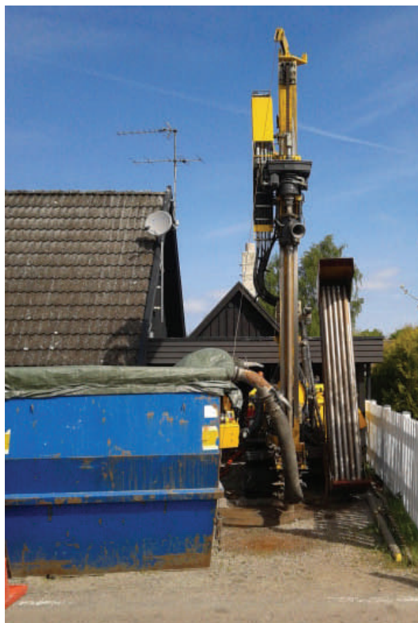
Fig. 2: Rigg för sänkhammarborrning med tillhörande sedimentationscontainer.
