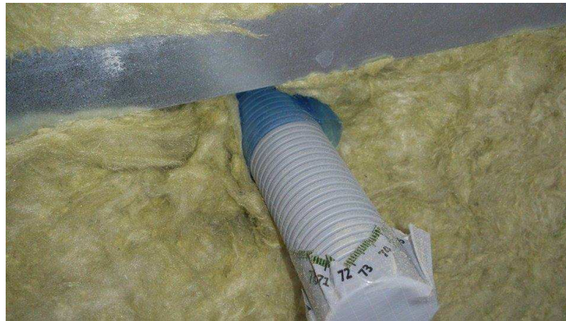
Figur 8-6 Plastfolie med kragfunktion runt installation, (Egentagen bild, 2014)
