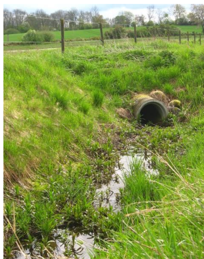
Figur 2. Ett utlopp för dräneringsvatten från jordbruksmark i Torpsbäckens avrinningsområde. Foto: Jenny Ahlstrand
