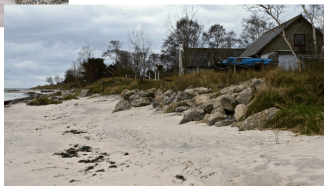
Figur 2.5. Stenblock har placerats framför fastigheten för att förhindra sandflykt. Foto A. Fast
