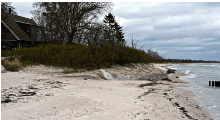
Figur 2.6. Tomtgränsen har förstärkts med strandkoning för att förhindra erosion.
