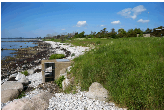
Figur 4.9. Breddningsledningen i område A. Pumpstationen kan skimras till höger i bilden. Foto A. Fast
