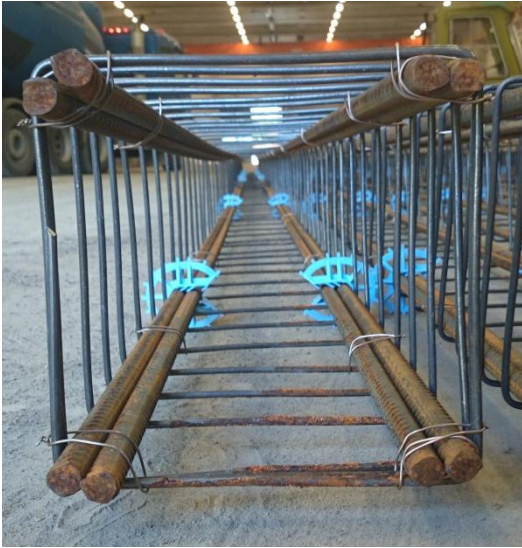
Figur 4.2 Armeringstål för pålar (Johansson 2014)
