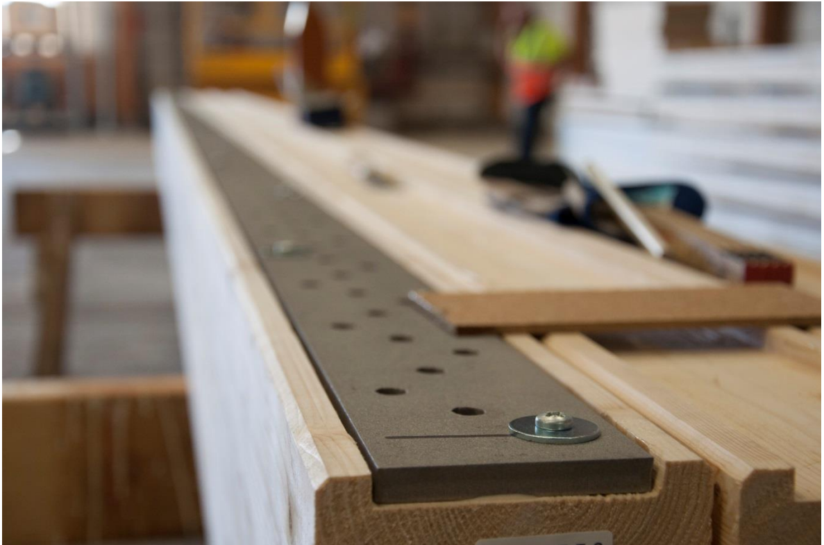
Figur 6.11 – Fastskruvade stålförstärkningar
