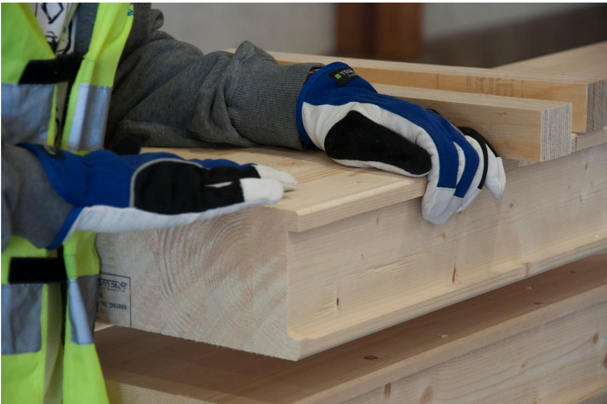
Figur 6.4 – Urfräsning till stålförstärkningen (80x10 mm).
