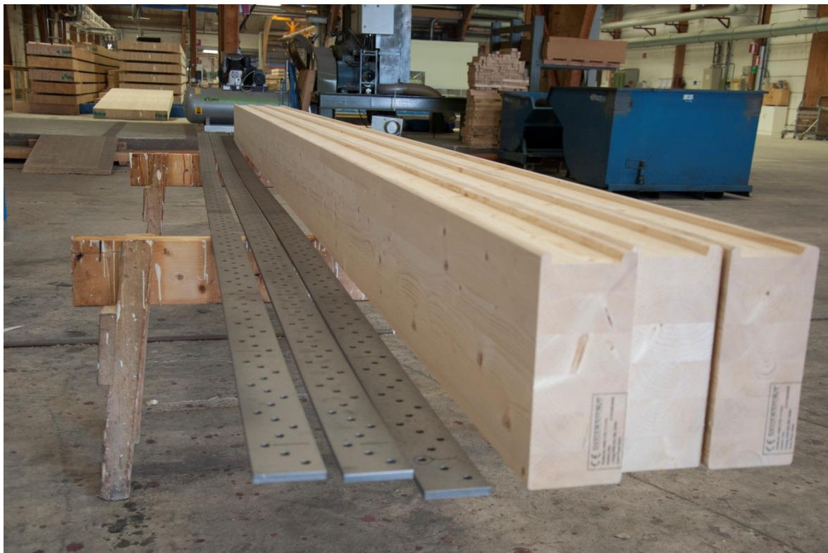
Figur 6.5 - Förberedning för montage av stålförstärkning
