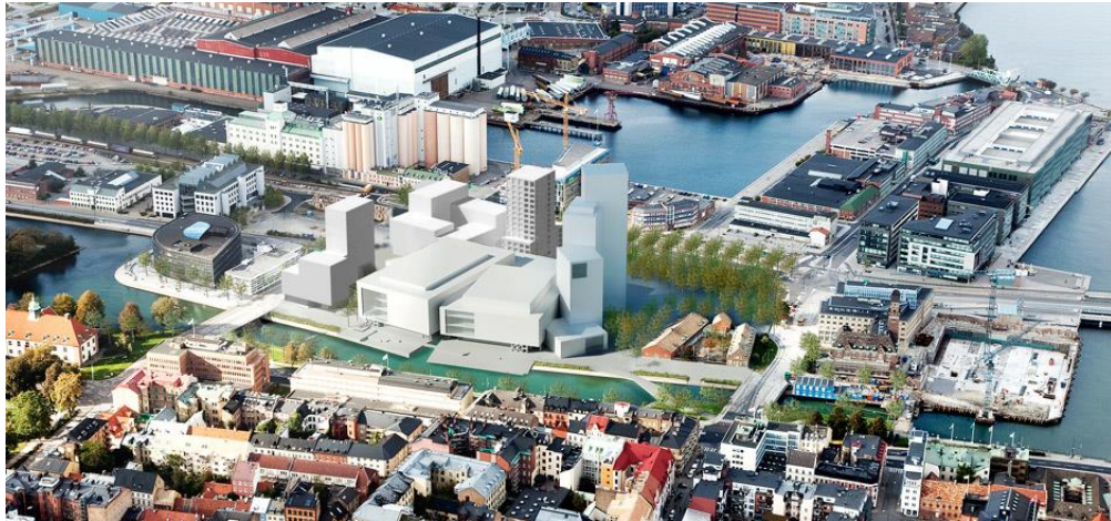
Figur 1: Malmö Live området, Källa: http://www.malmolive.se/sv/platsen
