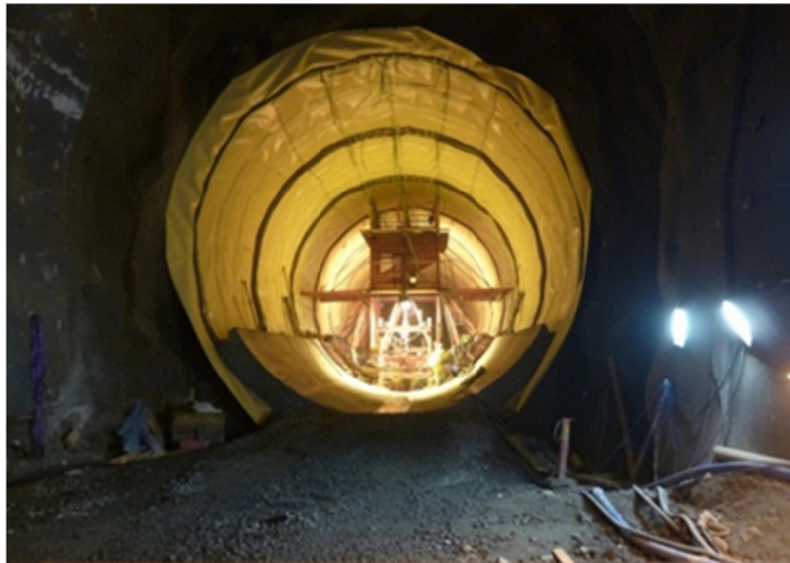
Figur 6. Bilden visar pågående byggprocess vid bygget av Hallandsås tunneln som är en enkelspårig borrhad betongjärnvägstunnel vars gångvägar i ett senare skede av byggprocessen ska placeras i rälsnivå. Bild: Emma Dahlstrand, 2013
