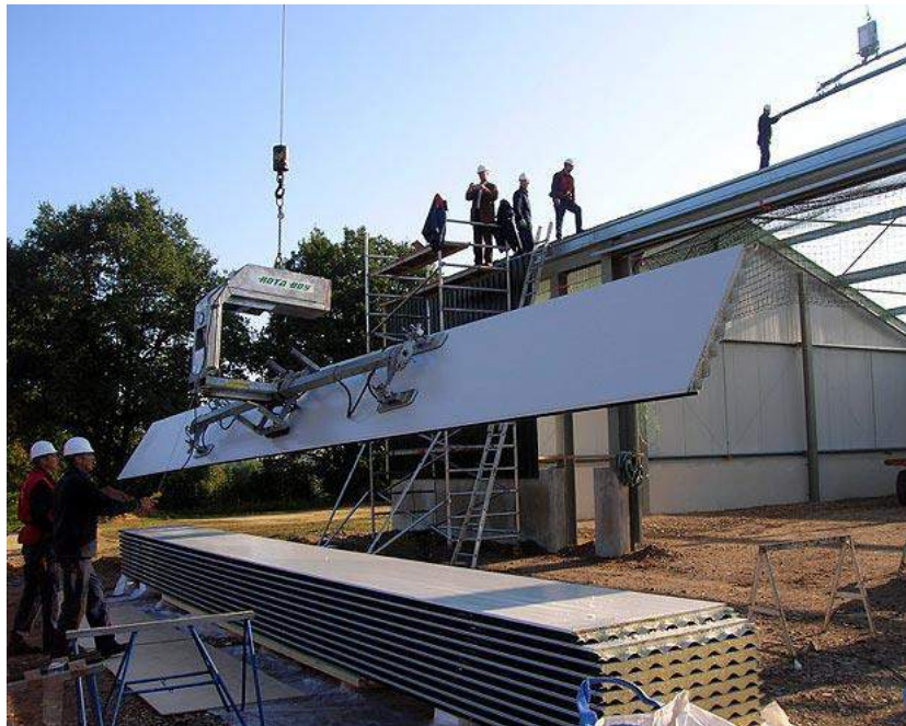
Figur 5 Installation av takelement (arlift, 2014)
