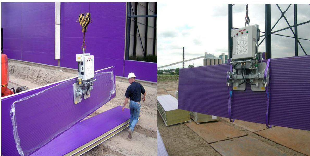
Figur 6 Visar installation av väggelement (arlift, 2014)
