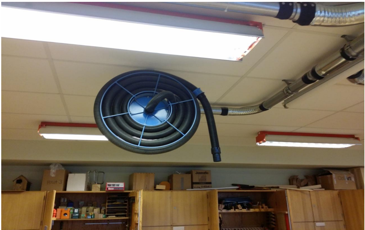
Figur 4.13 Mobilt utsug för städning runt arbetsbänkarna.
