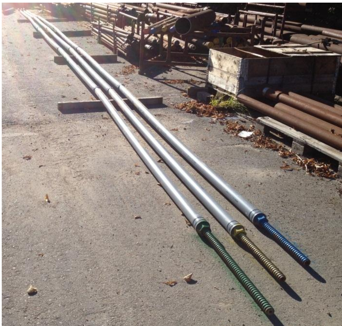
Figur 6. Färdigmonterade stag redo att installeras (FOTO: Jonas Nilsson).
