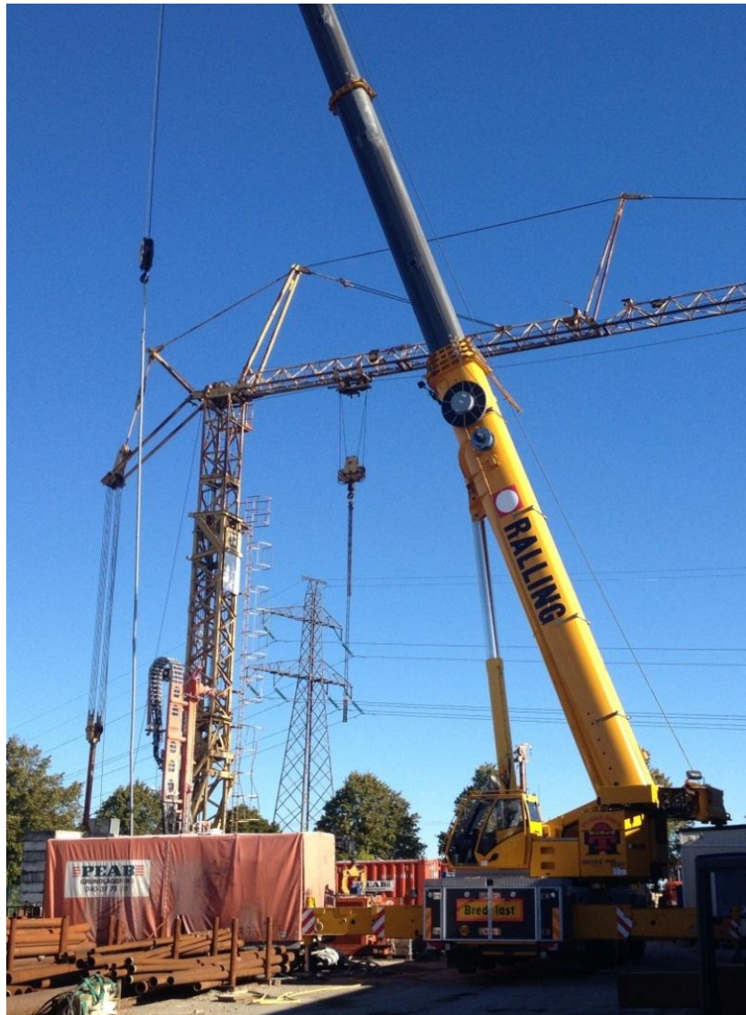
Figur 7. Installering av dragstagen (FOTO: Jonas Nilsson).
