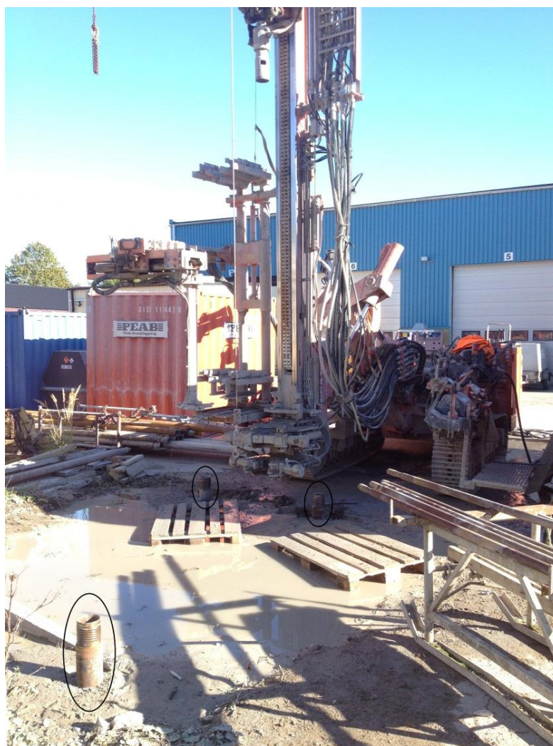
Figur 5. Rören som stagen skall installeras i (FOTO: Jonas Nilsson).
