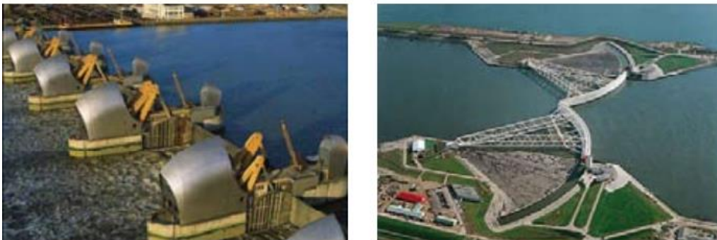
Figur 13 – Den stora rörliga Themsenbarriären i London och Deltaplanbarriären i Holland (Malmö stadsbyggnadskontor, 2008).
