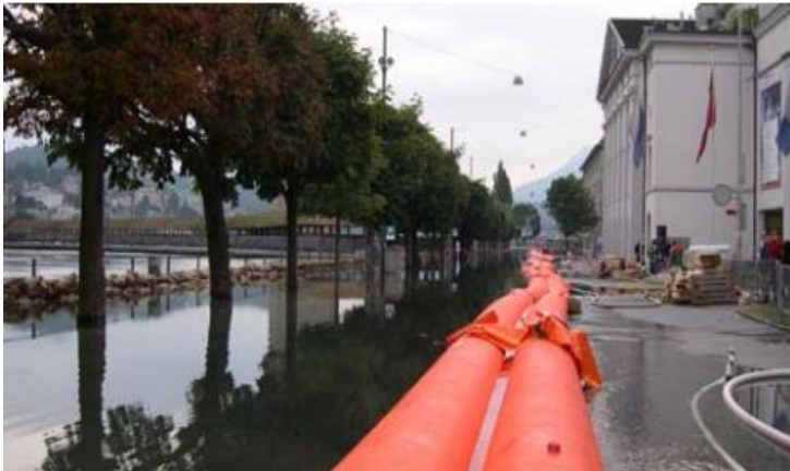
Figur 10 – Vattenfylld plastslang, läggs ut vid högvatten (Malmö stadsbyggnadskontor, 2008).
