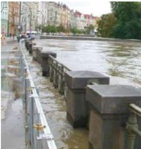
Figur 11 – Tillfällig monterbar barriär används vid höga vatten (Malmö stadsbyggnadskontor, 2008).
