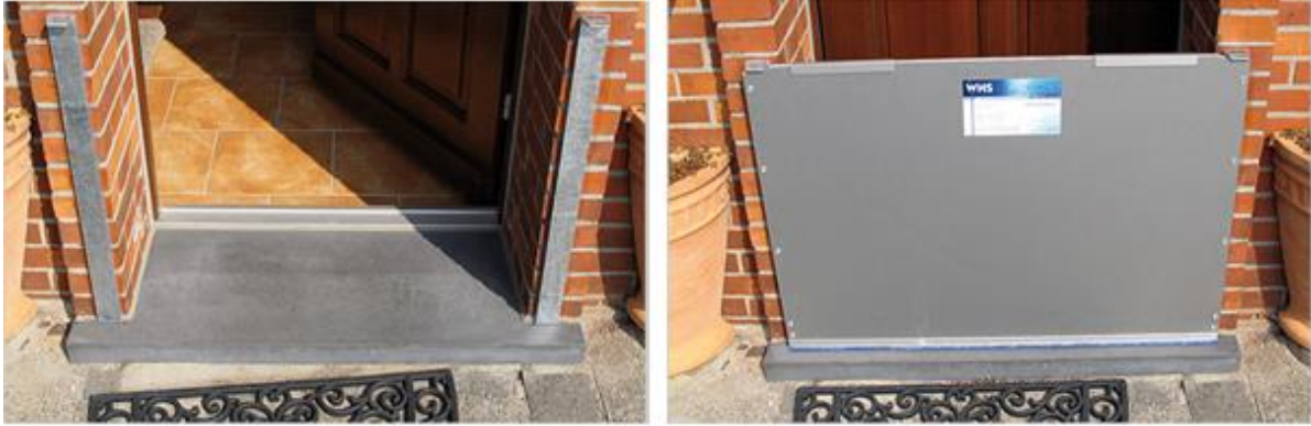
Figur 12 – Lösningar mot vattengenomtränglighet i hus ( (WHS, 2014).
