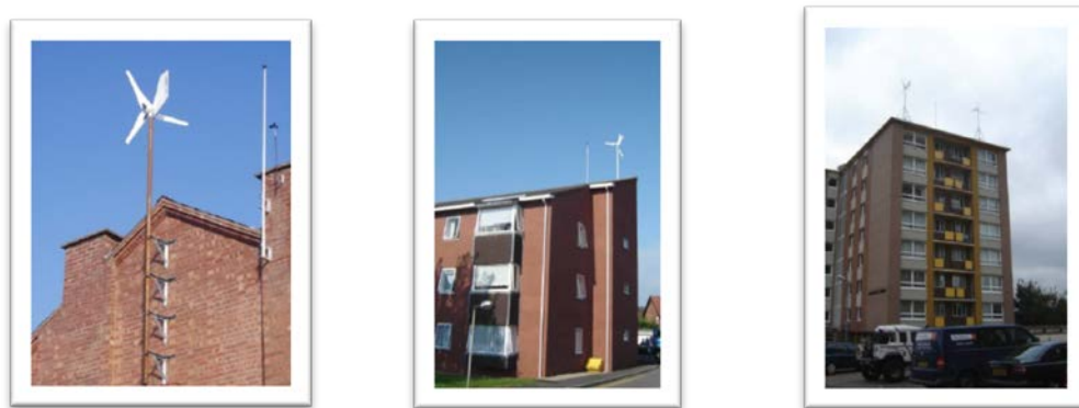
Figur 32: Olika placeringar av små vindturbiner på byggnader i urban miljö [27]
