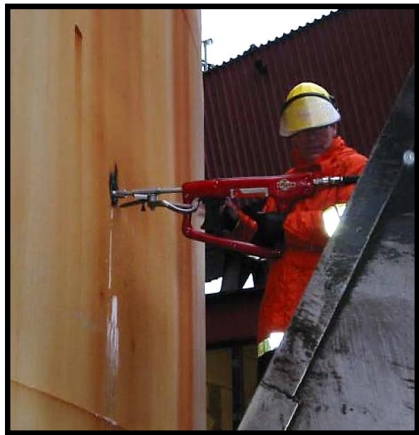
Figur 11. Begränsad åtkomst till silo vid släckinsats. Fotograf: Martin Uulas
