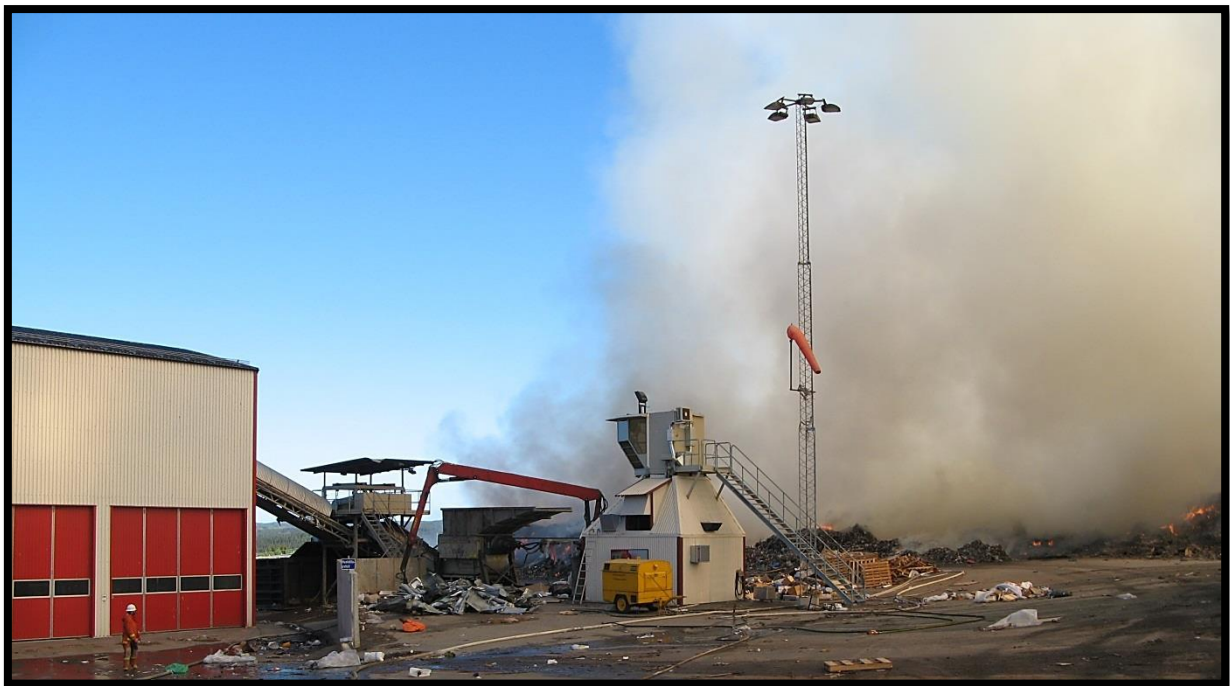
Figur 10. Brand i lagring av verksamhetsavfall utomhus. Brandorsak självantändning. Fotograf: Martin Uulas
