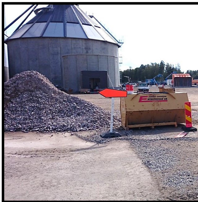
Figur 8. fristående stål- och betongsilo. Fotograf: Christian Jönsson
