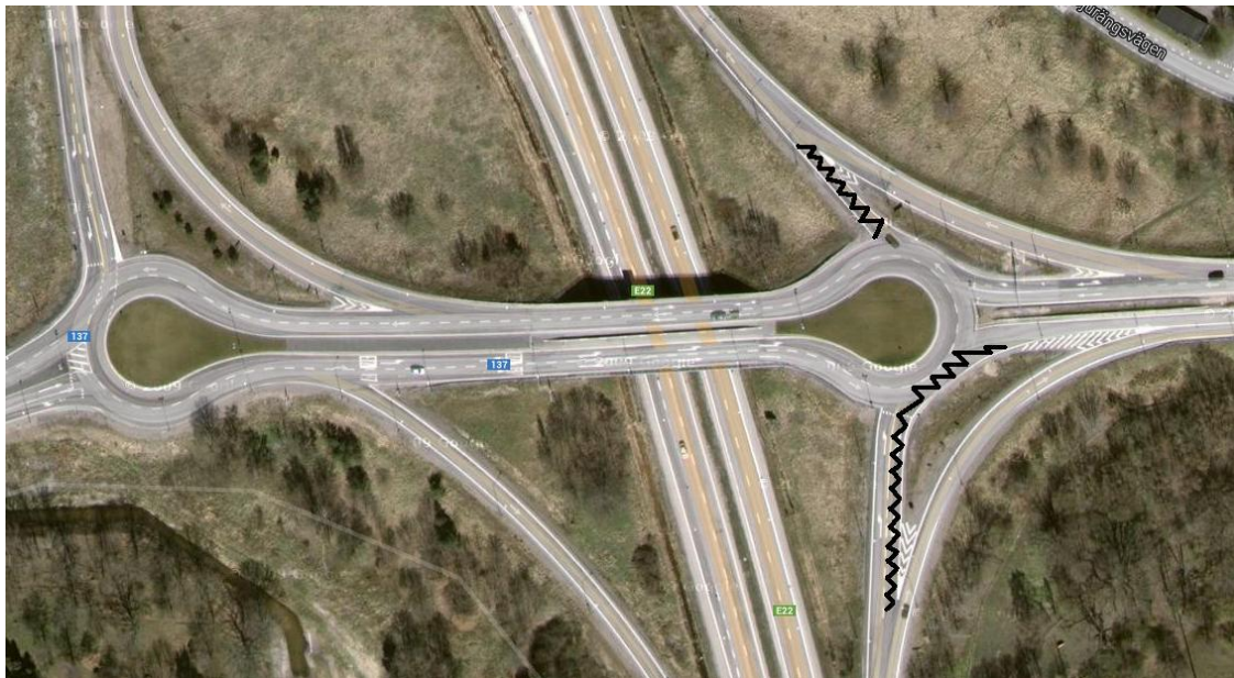
Figur 14. Avstängning av påfarten till E22an samt ett av avfartens körfält.
