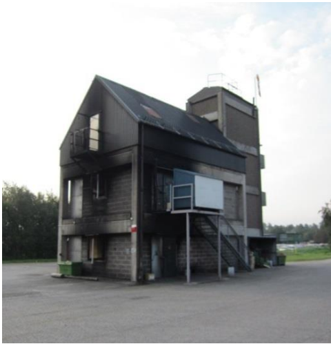
Figur 1- Brandövningshuset sett från nordväst.
