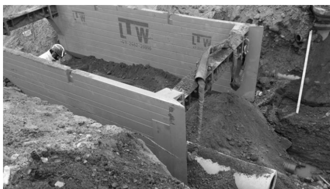
Figur 45. Översiktspild schakt med schaktsläde.
