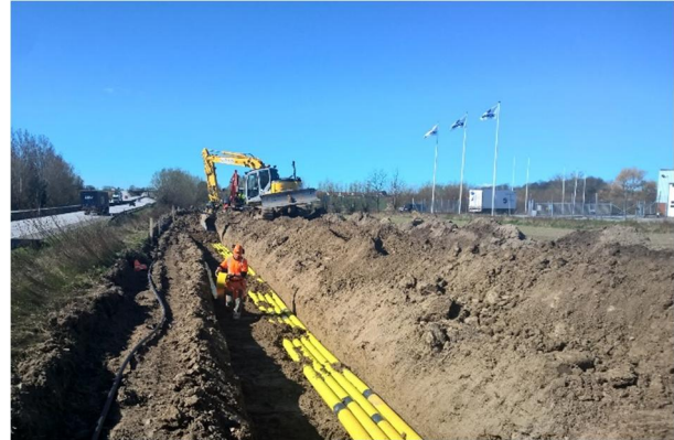
Anläggningsarbete av ledning i sydöstra Lund. Foto: Klas Bergström
