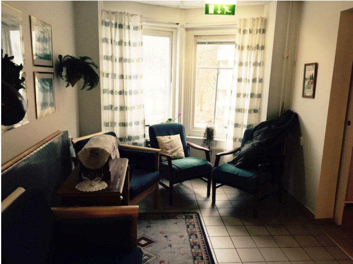
Figur 4.1. Dagrum i korridor. I bakgrunden syns en blockerad nödutgång via fönster som leder till den utvändiga spiraltrappan. Notera också rampen som står lutad mot väggen bakom möblerna till vänster i bilden. Fotografi: Gustaf Berglund
