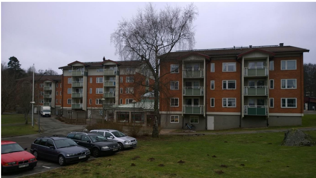
Figur 3.2. Västralid äldreboende. Till höger närmast i bild syns Hus 10, längre bak syns Hus 9 och längre bak till vänster syns Hus 8. Fotografi: Bjarne Husted.
