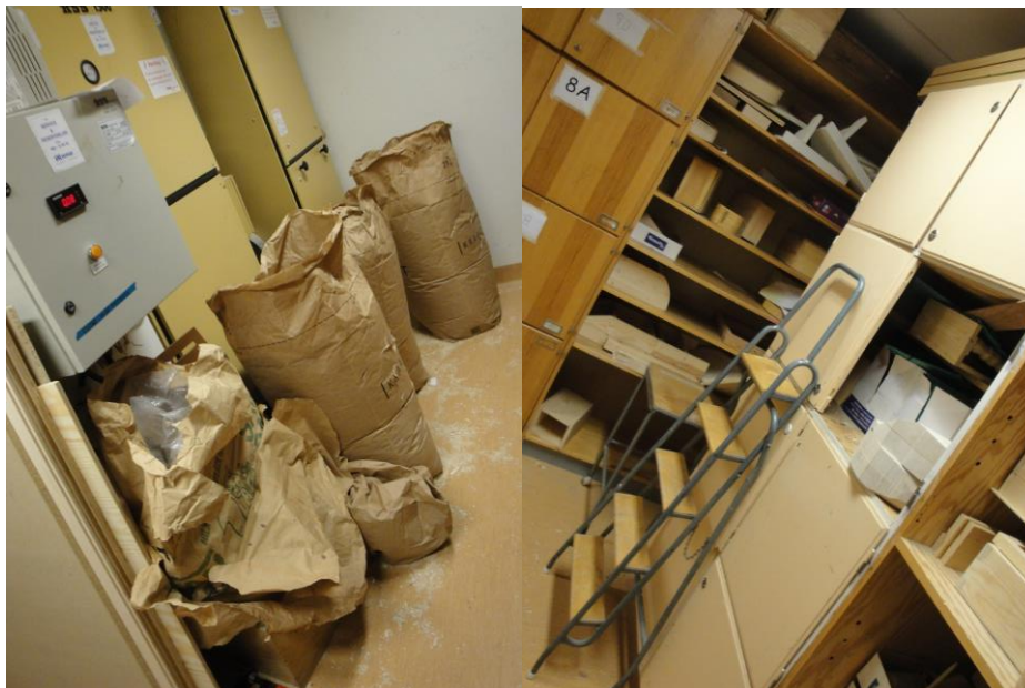
Figur 6-7 Till vänster: Ett antal spånsäckar förvarades i anslutning till spånsugan. Till höger: I förrådet vid träslöjden förvaras även elevarbeten. Bild: Sofia Majtorp.
