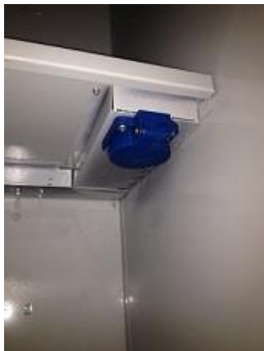
Figur 6-9 I skåpen finns eluttag monterade på undersidan av hyllplanet i varje skåp. Bild: Sofia Majtorp.
