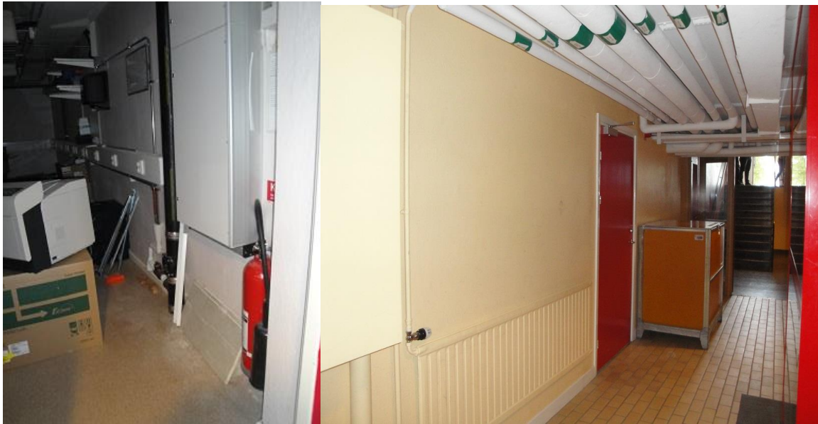
Figur 6-4 Till vänster: Serverhallen. Till höger: Bilden visar källarkorridoren. Dörren på bilden leder inte in till serverhallen. Bild: Sofia Majtorp.
