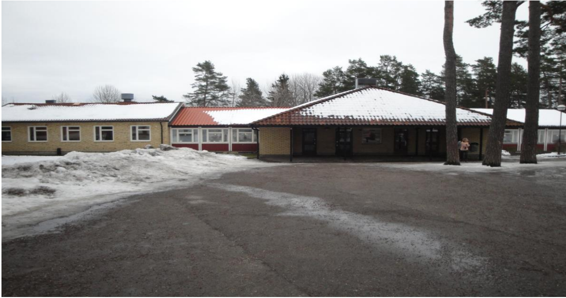
Figur 2-10 Byggnad B från utsidan. Bild: Sofia Majtorp.
