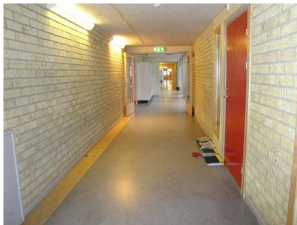
Figur 2-13 Korridorerna i byggnad C är sparsamt möblerade. Bild: Sofia Majtorp.
