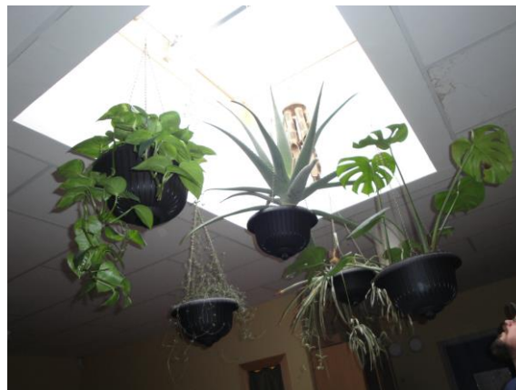
Figur 5-6 Rökluckan i byggnad C används som upphängningsanordning för växter. Bild: Sofia Majtorp.
