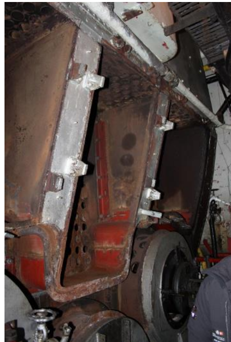
Figur 11 - Bild över en ångpanna med skyddskåpa bortmonterad. Bild tagen i pannrum.
