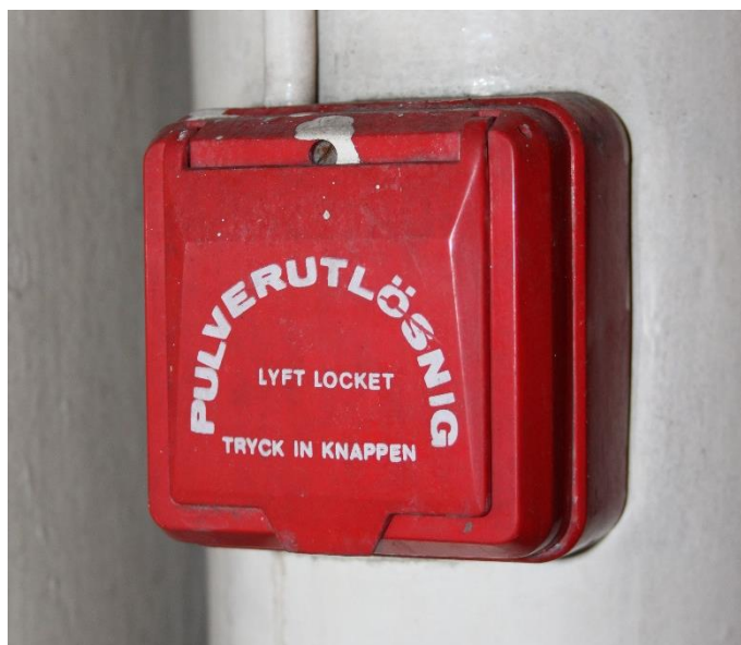
Figur 7 - Knapp för manuell aktivering av pulversprinkler. Aktuell knapp finns i anslutning till en värmepanna i främre maskinrummet.
