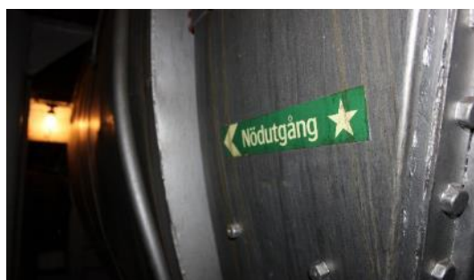
Figur 46 - Exempel på skyltning för att göra besökarna varse om utrymningsväg.
