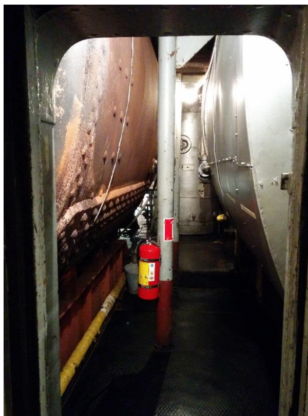
Figur 50 - Passagen mellan pannrummet och det akter maskinrummet.
