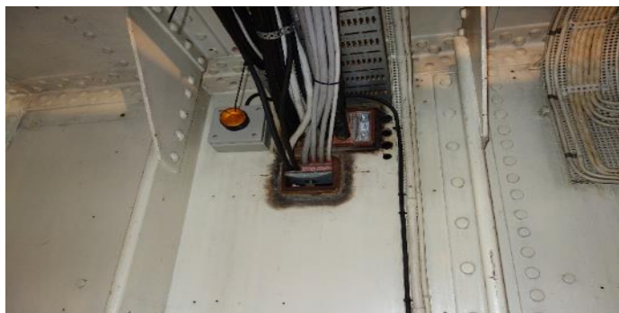
Figur 44 - Påbörjade brandtätningar mellan akterförrådet och maskinrummet.
