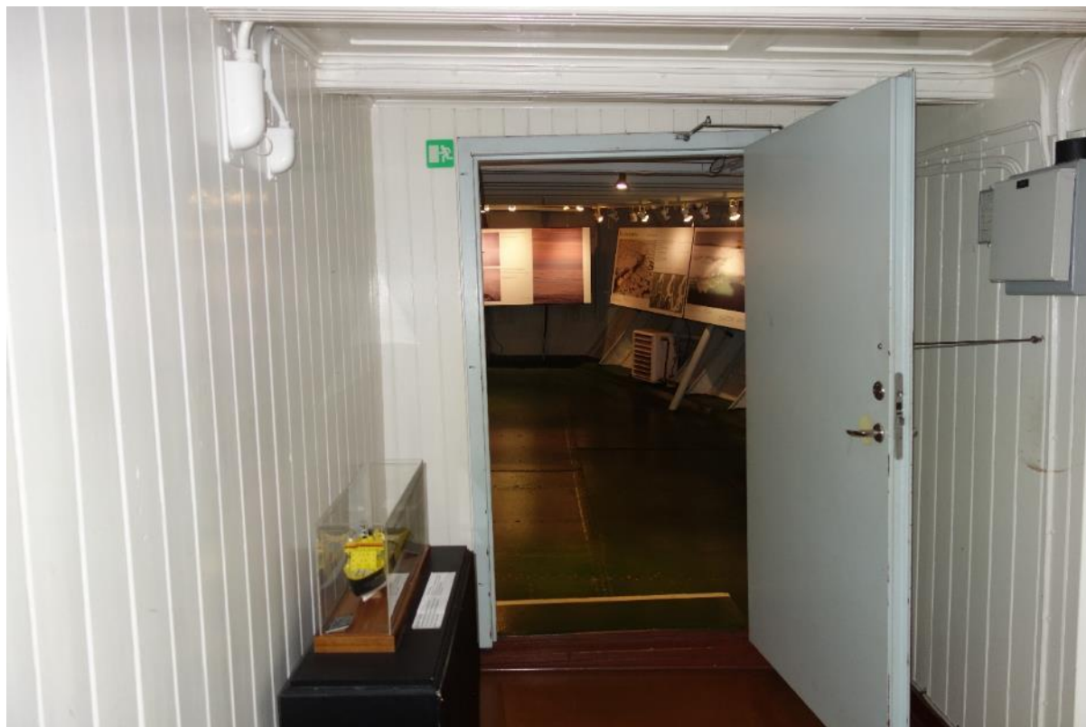
Figur 24 – Branddörren in till utställningshallen som åtgärden med elektromagnetisk dörrhållare avser.
