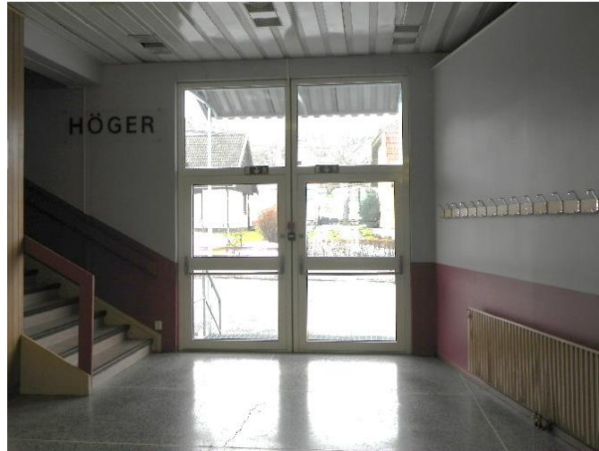
Bild 2. Nödutgång i övre foajén. Förrådet är till höger i bild bakom väggen. (Platsbesök 19/2-2014)
