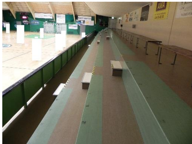
Bild 3. Norra läktaren i idrottshallen. (Platsbesök 19/2-2014)
