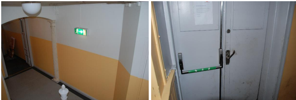
Bild 4.7. Bilderna visar utrymningsvägen i trapphus 2. Den vänstra visar hallen som trappan leder till i markplan. Bilden till höger visar dörren ut mot bakgården.
