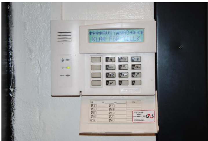
Bild 4.1. Bilden visar manöverpanelen för inbrottslarmet och brandlarmet.
