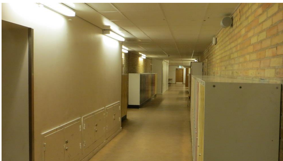
Figur 29 Bild på våning två av korridor i motsatt riktning.
