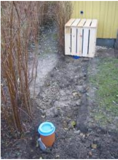
Figur 5. Bild över mullfilter, men filterdelen närmast huset och resorptionsdiket efter häcken. Källa: (Skarpnäcks stadsdelsförvaltning, 2007 s 4).
